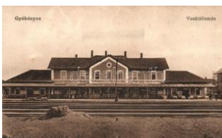
20475. ☒ Gyékényes, Vasúttalomás (kis szakadás) 1000
