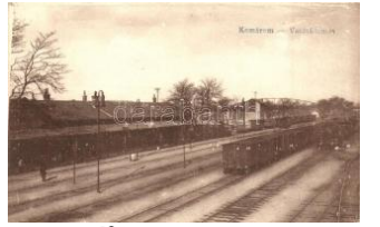
21266. * Komárom, Komárom; vasútállomás, vag 12000
