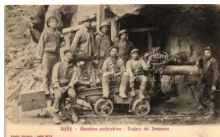
21828. Iselle, Macchina perforatrice, Traforo del 8000
