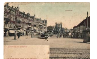
21766. * Dresden, Schillerplatz / square, tram shop 1400
