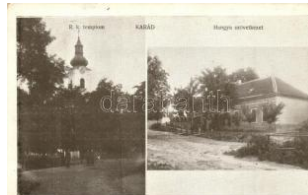
20537. ☒ Karád, Hangya szövetkezet, Római kató 1600
