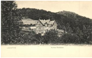
21743. ** Bad Laasphe, Kurhaus Kohlstadt / spa 1200
