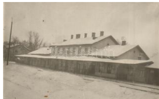
21055. ✱ Bányu, Batyovo; Vasútállomás télen / railw3000
