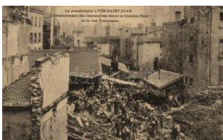
21562. ** Lyon-Saint-Jean, l'eboulement / landslide 3000
