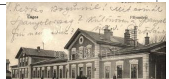
20705. Lugos, Lugoji; vasútállomás / railway stat 3800
