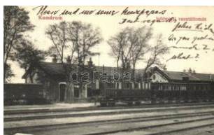
20956. ☒ Komárom, Komárom; Jobbparti vasútálló 5500
