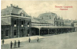
20308. ☒ Cegléd, Vasútállomás, W. L. Bp. 6116. T 5500
