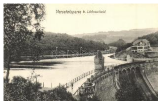
21712. Versetalsperre b. Lüdenscheid, dam T 1000
