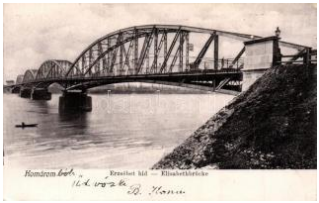
20962. ☒ Komárom, Komárom; Erzsébet híd / Elisa 3000
