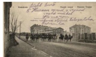
20953. ☒ 1915 Komárom, Huszár csapat / Husaren 6000
