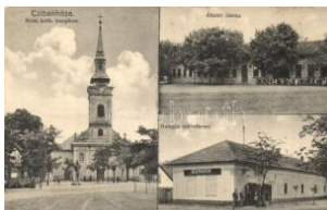
20311. ☒ Cibakháza, Állami iskola, hangya szövetk 3000
