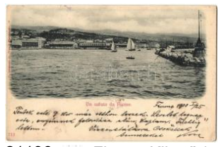
21136. ☒ Fiume, Kikötő / port T2 1200
