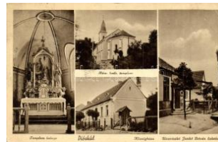
20329. ☒ Dióskál, Római katolikus templom, belső 1800
