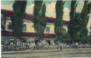
20547. ** Szentés, vasútállomás, vendéglő, étterem 1400
