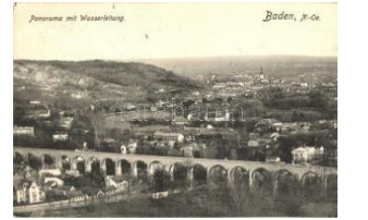
21289. ☒ Baden, Panorama mit Wasserleitung T1 1200
