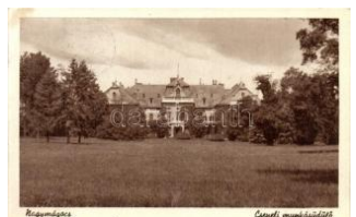
20465. ☒ Nagymágocs, Csépeleli munkásüdülő (EK) 1400
