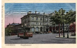
21687. ☒ Chemnitz, Hauptbahnhof, Nicolaibahnho 1800
