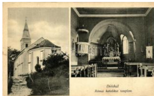
20330. ☒ Dióskál, Római katolikus templom, belső 1800
