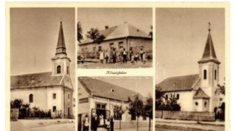
20361. ✖✖ Győrújbarát, Na gybarátfalú; Községház 2000
