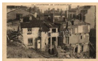
21564. ** Lyon-Saint-Jean, l'eboulement / landslide 3000
