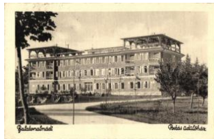
20159. ☒ Balatonalmádi, P ostás üdülőház T2 1200
