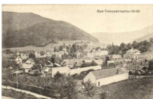
21042. ** Trencsénteplic-fü rdő, Trencianske Tep 1200
