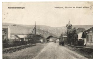
20708. Máramarossziget , Thököli út, Sóvasút, G 3000
