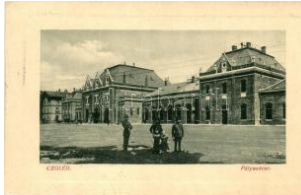
20307. ☒ Cegléd, Vasútállomás, W. L. Bp. 6114. T 5500
