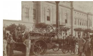
20425. * Makó, Fő tér, Városház, gőzgép, photo 3000
