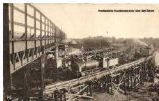
21573. * Narew, Provisorische Eisenbahnbrücke 4000
