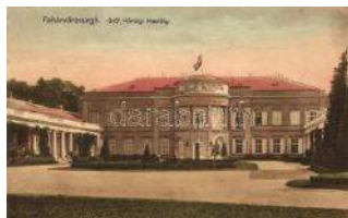
20293. ☒ Fehérvárcsurgó, Gróf Károlyi kastély, Ha 4000
