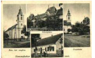
20444. ☒ Nemesnádudvar, Községháza, Római ka 1800
