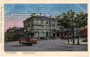
21624. ☒ Chemnitz, Hauptbahnhof, Nicolaibahnho 1800
