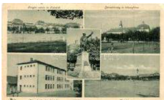
20432. ☒ Mór, Polgári iskola és Takarékszövetkezet 1000
