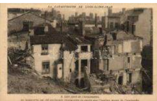
21508. ** Lyon-Saint-Jean, l'eboulement / landsl. 3000
