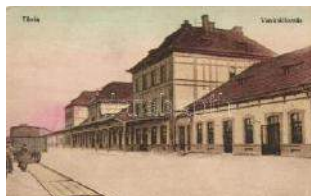
20841. ☒ Tövis, Teius; vasútállomás / railway stat 1400
