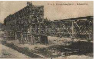
21912. ☒ Kohnbrücke. K.u. k. Eisenbahnregiment B3000
