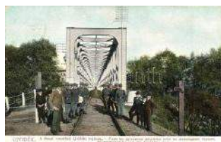
21230. ☒ Újvidék, Novi S ad ; a dunai vasúti híd újvi 4800
