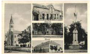
20398. ☒ Lajosmizse, Római katolikus templom, K 1000
