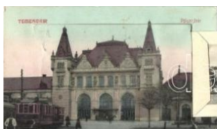
20988. ☒ Temesvár, Timiso ara; vasútállomás villam5000
