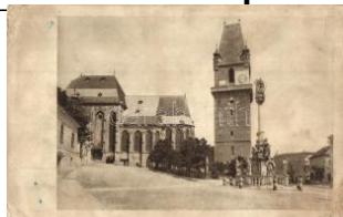
21290. * Perchtoldsdorf, Pfarrkirche, Türkenturm / c800
