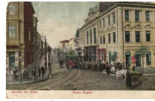
21532. * Braila, Strada Regala / street view with tra 2000
