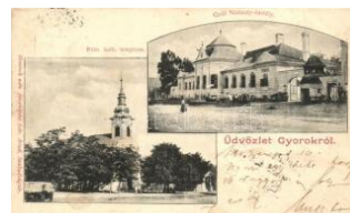
20860. Győrök, Ghioroc; Római katolikus templom 7000
