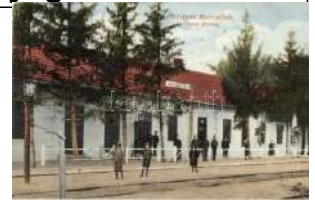
20913. ☒ Marcali, vasútállomás, Mizsur Adámné k 3800
