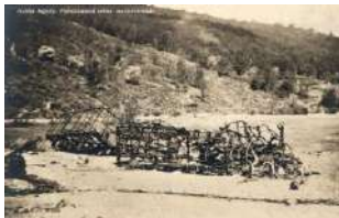
23163. ** Kotilla Károly fe lvétele: Felrobbantott o 2000
