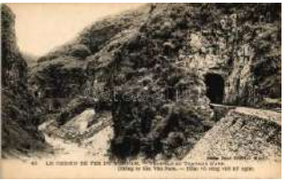
22498. ** Yunnan, Chemins de fer, Tunnel et Tra 3000
