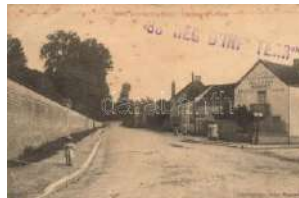
22408. ☒ Cusy, L'Avenue de la Gare / street, cafe, 2000
