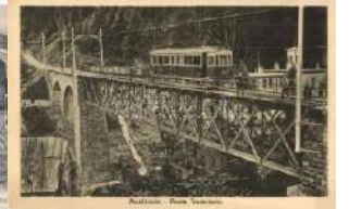
22664. ** Mostizzolo, Pon te Tramviario / tramway 2800
