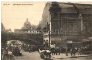
22558. ** Berlin, Bahnhof Friedrichstrasse / railw 1400
