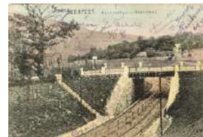
20351. ☒ Budapest II. Hűvösölgy, vasúti hid (EK) 1000
