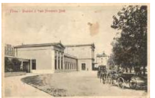
21994. * Fiume, Vasútállomás és Deák Ferenc út 3000
