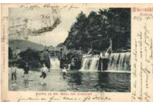
22246. ☒ Mürzzuschlag, Partie an der Mürz mit Cu 2600
