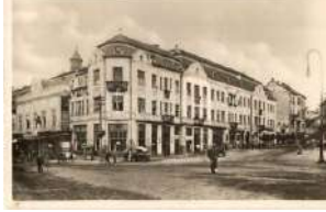
20842. ☒ Kaposvár, Korona szálloda, Korona illats 2200
