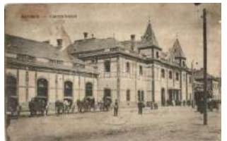
21159. * Szolnok, vasútállomás (ázott / wet damag) 1000
