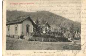
21912. * Vihnyefürdő, Kúpele Vyhnye; Pfeilmajér 3600
