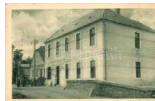
20151. ☒ Balatonarács, Szövetkezet és posta T2 3000
