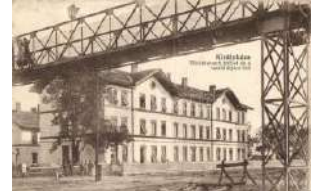
21933. * Királyháza, Koroleve; Vöröskereszt épülete 2200
