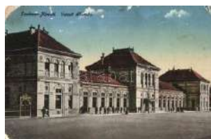
21508. ☒ Szatmárnémeti, Satu Mare; Vasútállomás 1600
