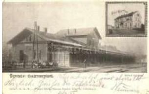
22172. Csáktornya, Cako vec; Vasúti indóház, va 8000
