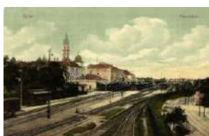
20780. ☒ Győr, vasútállomás T2 1800
