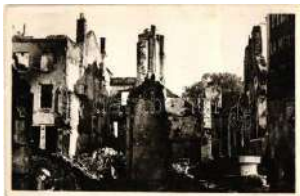
22414. ** Hennebont, Sinistré, Puits Ferré / disas 2000
