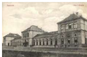
21504. ☒ Szatmárnémeti, Satu Mare; Vasútállomás 4000
