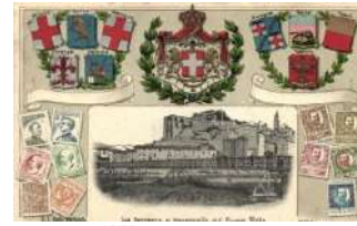
22681. Roia, La terrazza e passarella sul fiume; 3000
