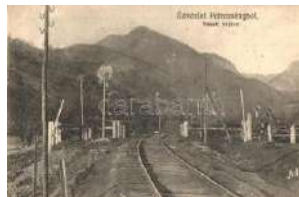
21472. ✱✱ Petroszény, Petrosani; vasúti bejáró. A 3000
