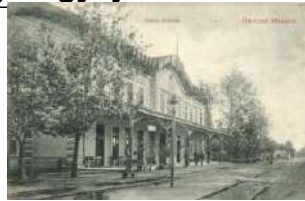
20912. ** Makó, Vasútállomás, Vészi Dezső kiad 2600
