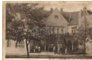
21652. ☒ Ipolyvás, Sahy; Posta épület / Postová b 2000
