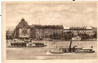
21807. ☒ Pozsony, Pressburg, Bratislava; Vigadó, 2000
