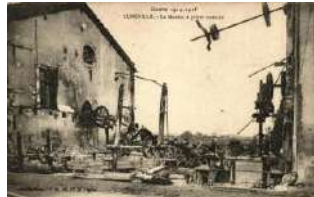
22423. * Lunéville, Moulin a platre incendie / destr 2000
