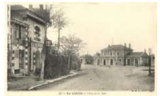
22417. ** La Chatre; Plac e de la Gare / square o 3000
