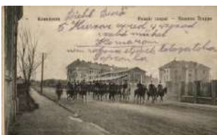
20992. ☒ 1915 Komárom, Huszár csapat / Husaren 6000
