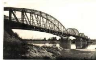
21000. ☒ Komárom, Komárom; híd / bridge (EK) T 1000
