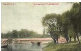
20144. * Budapest II. Hűvösvölgy, Ördög-árok, híd 2400
