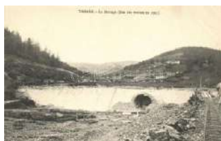
21560. ** Tarare, Le Barrage / dyke T1 2800
