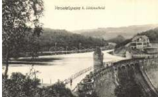
21740. ** Versetalsperre b. Lüdenscheid, dam T 1000
