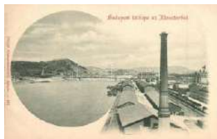
20283. ** Budapest IX. Látkép az Elevator épület 1600
