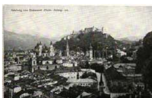
21305. Salzburg vom Restaurant 'Elektr. Aufzu' 1000
