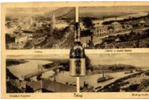
20650. ✱✱ Tokaj, Vasúti híd, Erzsébet Tisza híd, T 1000
