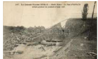
21490. * Aspach (Haut-Rhin) Le Pont / war damag 3000
