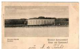
20989. ☒ Komárom, Komárom; Monostori värerőd, 7000
