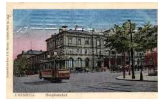
21674. ☒ Chemnitz, Hauptbahnhof, Nicolaibahnho 1800
