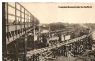
21601. * Narew, Provisoris che Eisenbahnbrücke / 4000
