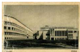
21205. * Újvidék, Kórház / hospital (Rb) T4 800
