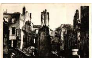
21817. ** Hennebont, Sin istré, Puits Ferré / disas 2000
