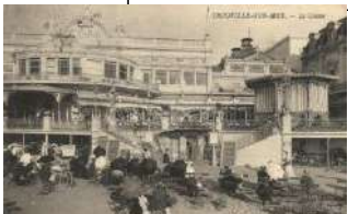
21853. ☒ Trouville-Sur-Mer, Le Casino / casino o 1000
