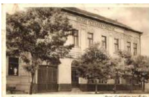
20109. ☒ Bácsalmás, Baji Takarékpénztár fiókja 2600
