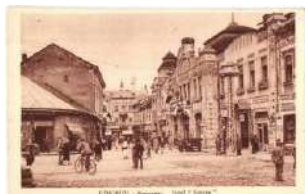
21604. ☒ Ungvár, Uzhorod; Hotel Koruna / Korona 2400
