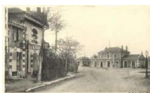
21818. ** La Chatre; Plac e de la Gare / square o 3000
