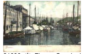
21636. Fiume, Canale de la Fiumara (fl) T3 1000
