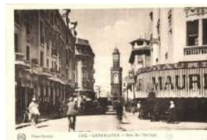
21935. ** Casablanca, Rue de l'Horloge / street, B1800
