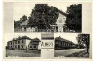
20102. ** Alberti (Albertirs), vasútállomás, Allam 3600
