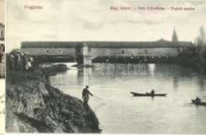
21127. ** Fogaras, Fagaras; Régi Olt híd. Thierfe 2000
