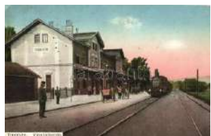
21913. Trencsén, Trencín; Vasútállomás, gőzm 2000
