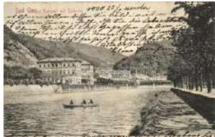
22256. ☒ Bad Ems, Kursaa l mit Bäderlei / spa build 1200
