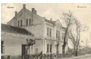
20762. * Gyoma, Vasútállomás, létrák (EK) T2/3 4000
