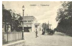
20749. * Gödöllő, Vasútállomás (EK) T2/3 2000
