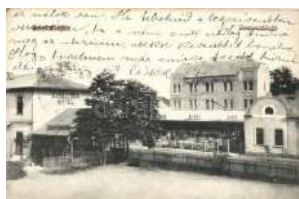
20169. ☒ Balatonboglár, vasút szálloda (EK) T2/3 3000
