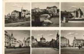
21592. * Nagyvárád, Oradea; Kőrös híd, Pannónai 1000
