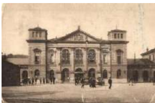
21858. ** Pozsony, Pressburg, Bratislava; Vasútá 2000
