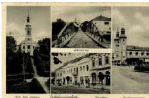
21646. ☒ Székelyudvarhely, Küküllő híd, Városház 1200
