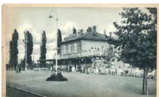
20176. ☒ Balatonföldvár, Vasútállomás (b) T4 1000
