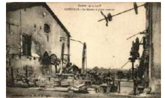
22217. * Lunéville, Moulin a platre incendie / destr 2000
