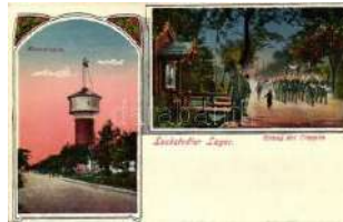
22340. ** Lockstedter Lager, Wasserturm, Einzug 4000
