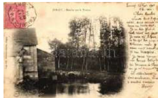
22215. Joigny, Moulin sur le Tholon / mill TCV (f 1000)
