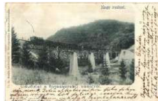
21909. Tiszolc, Tisovec; Nagy Viadukt, Tiszolc-E 3000
