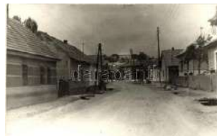
20630. ** Csolnok, Fő út, utcakép. photo (EK) T2 1600
