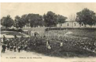
21484. ☒ Laon, Entrée de l a Citadelle / citadel T2 2000
