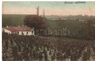
20545. ** Ostoros, szőlőtelep (ázott / wet damage) 1000
