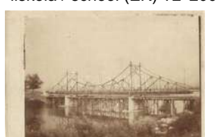
20790. ✱ Fenyőfalva-Felek, Bradu-Avrig; épülő híd 1800
