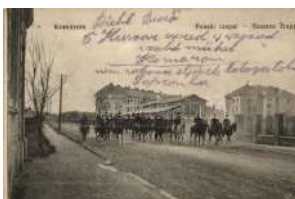
21012. ☐ 1915 Komárom, H uszár csapat / Husaren 6000
