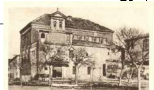
21723. ** Toledo, La Sinagoga del Tránsito / Syn 3000
