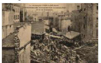
21493. ✱✱ Lyon-Saint-Jea n, l'eboulement / landsl 3000
