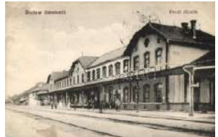
20097. ☒ Bánréve, Vasútál lomás T2 1800
