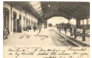
20519. ☒ Nagykanyizsa, vasútállomás, vagonok. Alt 4800
