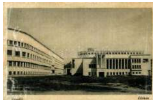
21233. ✱ Újvidék, Kórház / hospital (Rb) T4 800
