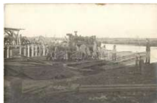
22033. ** Gőzgép tutajra helyezése a Bug folyón 1400
