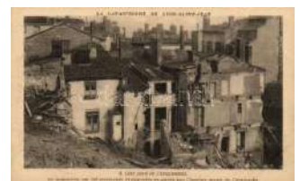
21491. ✱✱ Lyon-Saint-Jea n, l'eboulement / landsl 3000
