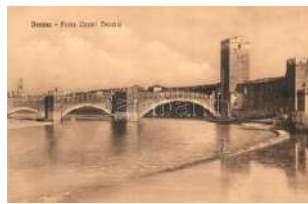
22316. ** Verona, Ponte Castel Vecchio / bridge T 1400
