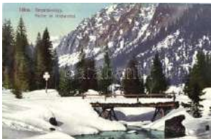
21667. ☒ Tátra, Tarpatakvölgy, híd. Cattarino S. ut 1800
