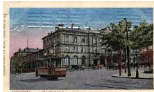
22104. ☒ Chemnitz, Hauptbahnhof, Nicolaibahnho 1800
