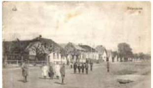
20932. Kál, utcakép (felületi sérülés / surface damage) 2000
