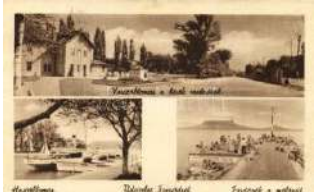
20743. ☒ Fonyód vasútállomás, hajóállomás, móló 800
