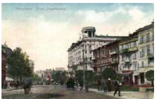
22027. ☐ Warsaw, Warszawa; Krak. Przedmieście 1200
