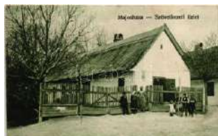
21016. ** Majosháza, Fogyasztási szövetkezet üz 2000
