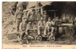
22249. * Iselle, Macchina perforatrice, Traforo del 6000
