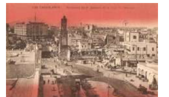
22062. ** Casablanca, Boulevard du 4 Zouaves, 1800
