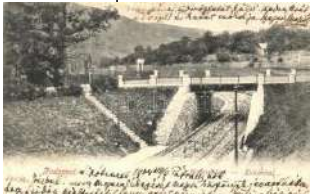
20215. ☒ Budapest II. Hűvösvölgy, vasúti híd T2 1000
