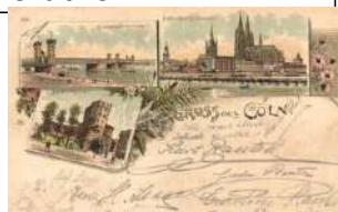
22138. ☒ 1897 Köln, Cöln, Cologne; Eisenbahnbrü 3000
