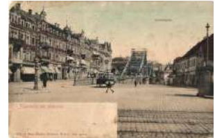
22110. * Dresden, Schillerplatz / square, tram shop 1400
