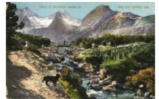
21658. ☒ Tátra, A Zöld-tóhoz vezető út, híd. Catta 1200
