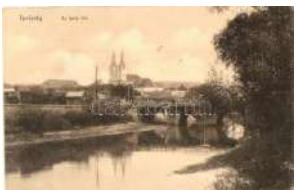
21245. ☒ Ipolyság, Saly; Ipoly híd / bridge T2 2200
