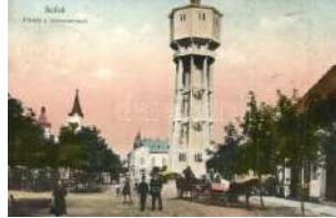
20840. ☒ Siófok, Fő tér, Víztorony (szakadás / tea 5500
