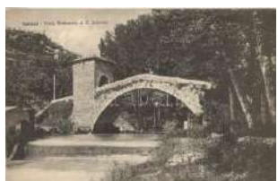
21872. ** Subiaco, Ponte Medioevale di S. Franc 1200
