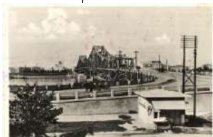
21555. ✱ Újvidék, Novi Sad; Közúti híd a szétrom 1200
