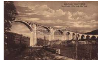
21654. ☒ Weiz-Birkfeld, Lo kalbahn, Grub Viadukt 2000
