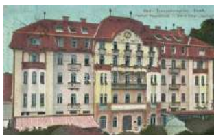
21383. ☒ Trencsentepl ic-fű rdő, Bad Trencianske T 1800
