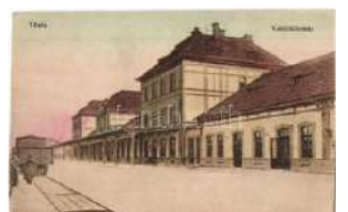
21189. Tövis, Teius; vasútállomás / railway stat 1000
