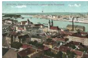
20221. ☒ Budapest I. Víziváros, kilátás a Halászbástya 1000
