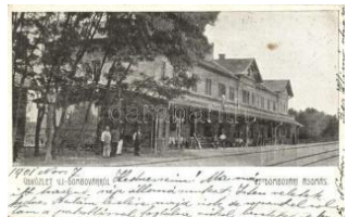
20323. ☒ Dombóvár, Újdombóvári vasútállomás (fa) 1400
