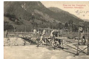
21798. ☒ Kaiserschützen, Notbrückenbau / WWI K. 2400
