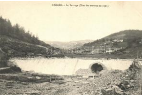
21321. Tarare, Le Barrage / dyke T1 2800
