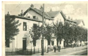
21004. ☒ Léva, Levice; Na drazie / Vasútállomás, 2400
