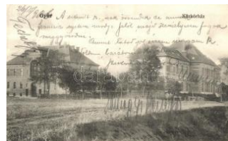
20357. ☒ Győr, Közkórház. Rembrandt fényirda (E) 1000
