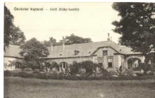
20695. 📷 Vajta, Gróf Zichy kastély. Fogyasztási sz 3600
