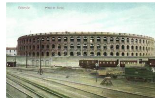
21630. ** Valencia, Plaza de Toros / arena, locom2000
