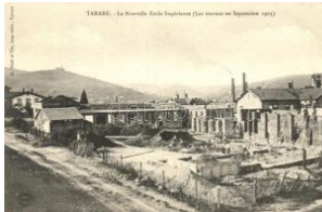
21320. Tarare, La Nouvelle Ecole Supérieure 2800
