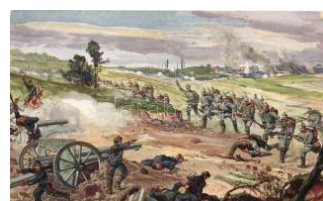
21866. ** Wegnahme ein er franz. Batterie / WW 1200
