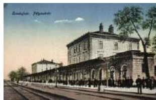
21628. ** Érsekújvár, Nové Zámky; Vasútállomás 1000
