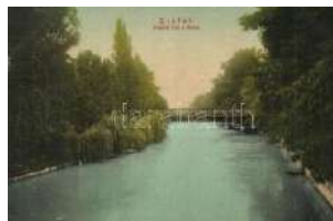
21197. ☒ Siófok, Vasúti híd a Sión T2 1400
