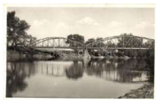
21410. ☒ Dés, Dej; Szamos híd / bridge T2 2200
