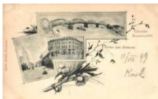
21662. ☒ 1899 Komárom, Komárom; híd, utca, üzle 4000
