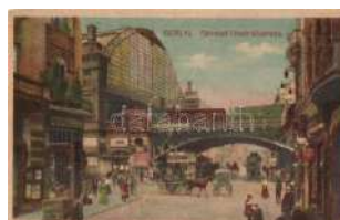
22332. ** Berlin, Bahnhof Friedrichstrasse / street 1000
