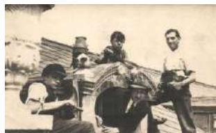
20180. ✱ Balatonkenese, épület tetején dolgozó bá 3200
