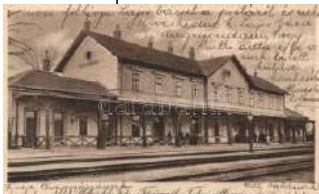
21298. ☒ Tata-Tóváros, T atai vasútállomás T2 2800
