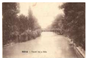
21200. ☒ Siófok, Vasúti híd a Sión T2 1000
