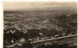
20670. ☒ Felsőgalla (Tatabánya), munkás telep T2 2800
