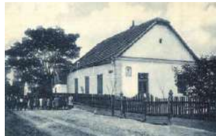
21240. ☒ Szalkszentmárton, Hitelszövetkezet T2/3 3600
