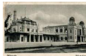
20250. * Békéscsaba, vasútállomás (EB) T3 1000
