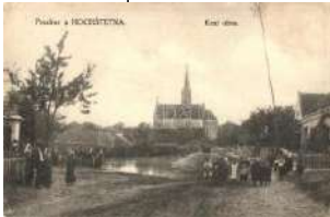
21681. * Nagymagasfalva, Magasfalva, Hochstett 5500
