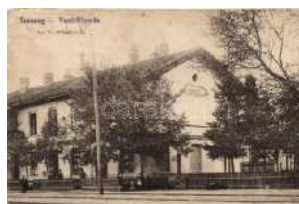
20589. * Isaszeg, vasútállomás (fa) T3 2000
