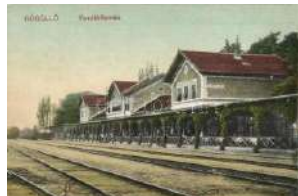
20496. ✱ Gödöllő, Vasútállomás (EK) T2/3 2000
