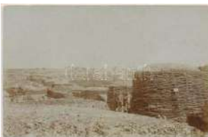
22465. 1916 Lövészárkok rendszer kiépítése 1800
