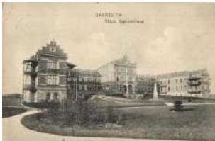
22197. ☒ Bayreuth, Städt. Krankenhaus / hospital 2000
