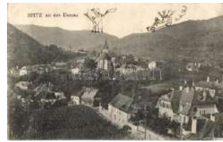
22076. Spitz an der Don au (wet damage) T4 1000
