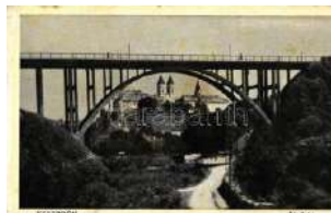
21088. ✱ Veszprém, viadukt (fa) T3 1000
