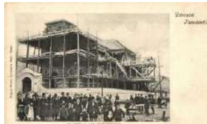
21526. Tasnád, épülő új római katolikus templom 4000
