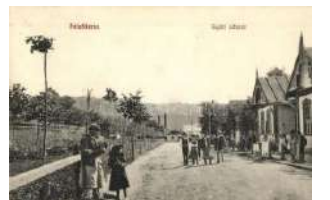
21286. ✱✱ Felsőderna, Demna; Gyári sétátér / prom 4800
