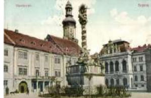
20893. ☒ Sopron, Városház tér, Szentháromság 1200
