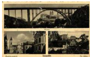
21089. ☒ Veszprém, viadukt, Szentháromság tér, vá 800
