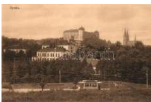
22309. ** Uppsala, Uppsala; tram T1 1600
