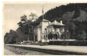
20469. ✱ Fonyód, Bélatelepi vasútállomás (Rb) T3 3200
