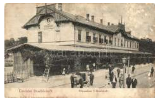
20426. ☒ Dombóvár, Ó-Do mbóvár, Vasútállomás, 1400
