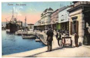
21687. ** Fiume, Riva Szapary / port, quay, stea 2000
