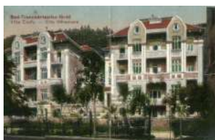
21643. ☒ Trencséntéplac, Trencianske Teplice; Vill 1000
