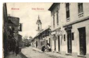
21493. ☒ Komárom, Komárom; Jókai Mór utca, Kő 4400
