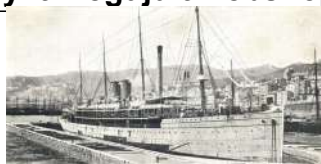
21936. ** Genova, Bacini di Carenaggio / Dry do 1600
