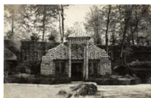
22249. ** I. zlj. segélyhely, kávéháza bejárata / WWI 1600
