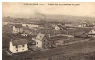
21832. ✱ Audincourt, Usines des Automobiles Peu 4000
