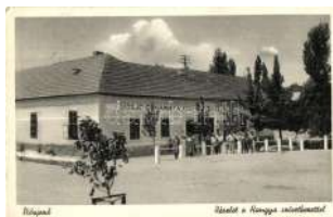
20423. ☒ Diósjenő, Hangya Fogyasztási Szövetkező 2000
