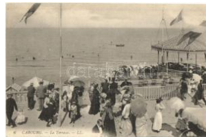
21994. ** Cabourg. La Terrasse / the terrace T2 2000
