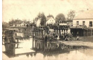
20397. ☒ 1936 Csesztreg, A híd építése, munkások 2800
