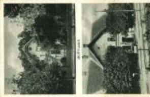
20736. Piliscsaba, Vasútállomás, MÁV üdülő, H 1800
