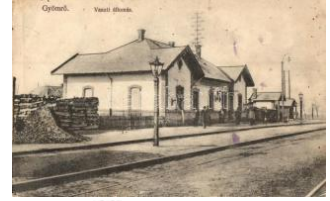
20494. ☒ Gyömrő (Kóczánpuszta), Vasútállomás 3600
