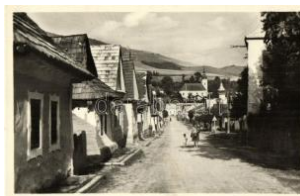
21513. ** Klenóc, Klenovec; utcakép / street view 1600
