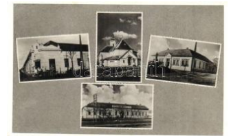
20642. ☒ Madaras, Római katolikus templom, Köz 2400
