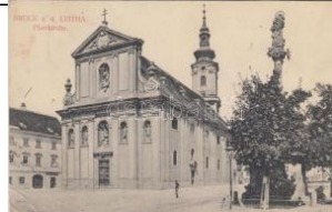
21862. 1911 Lajtabruck, Bruck an der Leitha; templom 3000
