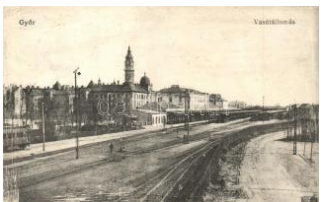
20503. ☒ Győr, vasútállomás T2/3 4400
