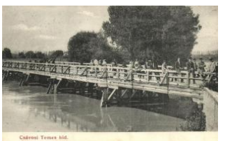
21023. ☒ Csávós, Temes Bridge. W3200
