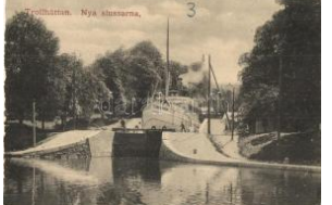
22300. ** Trollhättan, nya slussarna / canal, sluic 1400
