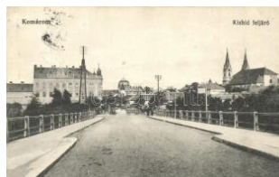
21520. ☒ Komárom, Komárno; Kishíd feljáró / bridge 2400
