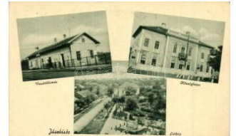
20546. ☒ Jászkisér, Vasútállomás, Községháza, lá 2800
