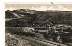
21795. ** Uzsok, Uzhok; viadukt / viaduct T2 1400
