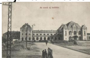
20964. * Arad, Új indóház, vasútállomás, építkezé 2000
