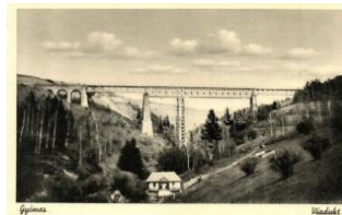
21108. ** Gyimes, Ghimes; Viadukt. Foto Seiwar 1600
