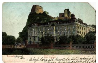
21886. ☒ 1904 Trencsén, Trencín; Erzsébet szálló 2800
