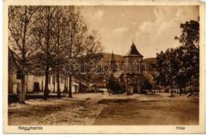
20680. 1928 Nagymaros, Fő tér, víztorony. Hévíz 2000
