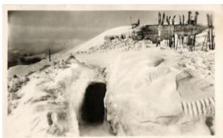
21824. ** Tátra, Nízke Tatry; Tunel ku vchodu St 1600
