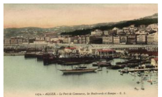
22227. Algiers, Alger; port (EK) T2/3 1000
