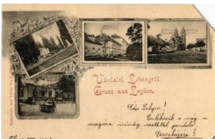
20593. ☒ 1898 Lébény, Vasúti indóház, vasútállom 2800
