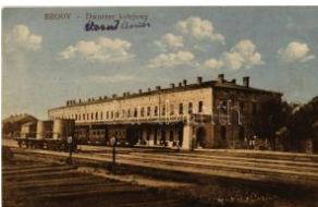
22641. ☒ 1916 Brody, Dwo rzec kolejowy / Bahno 3000
