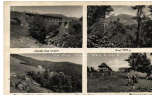
21983. ☒ Tiszaborkút, Viadukt, Sesul, Mencsul-úd 1000
