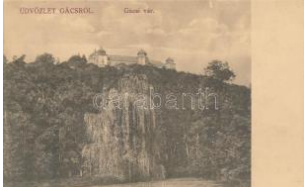
21421. Gács, vár / castle (wet damage) T4 1000
