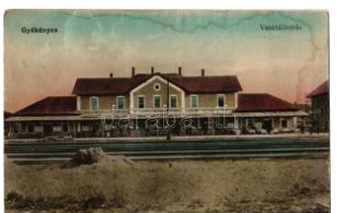
20444. 1917 Gyékényes, Vasútállomás (fl) T3 1600
