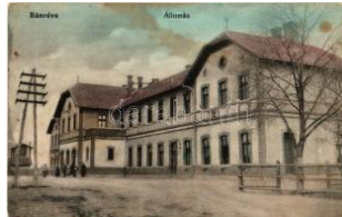
20169. ☒ 1914 Bánréve, Vasútállomás (fl) T2/3 1600
