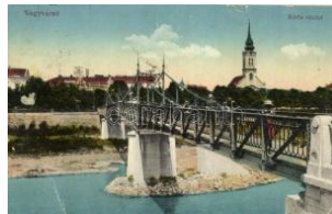
21230. Nagyvárad, Körös, híd / river, bridge (EB 2000
