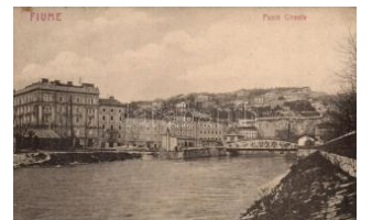
22076. ☒ 1907 Fiume, Rijeka; Ponte Girante / brid 3200
