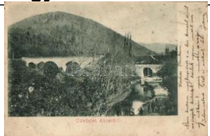
21345. ☒ Abos, híd / bridge (EB) T3 1600
