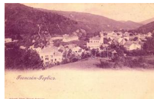
21892. ✱✱ Trencséntéplíc (ázott / wet damage) T4 1000
