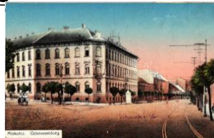
20642. Miskolc, Üzletvezetőház, villamosút. Sc 1200
