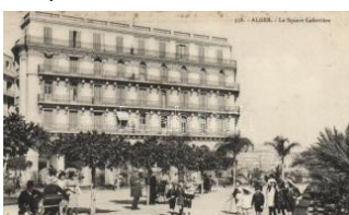
22237. Algiers Laferrière square (fl) T2 1400
