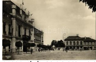
21036. ** Makó, Városháza, Korona szálló, Kecsk 2600
