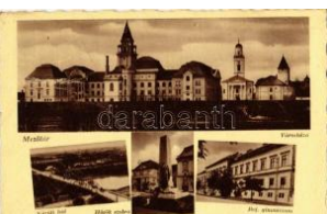
21075. ✳ 1940 Mezőtúr, Városháza, Közúti híd, Hó 1600
