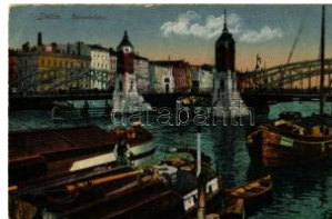
22780. ✳✳ Szczecin, Stettin; Hansabrücke / bridge 1400
