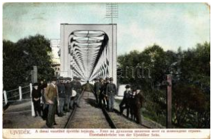
22682. ☒ Újvidék, Novi Sad; Dunai vasúti híd bejár 4000
