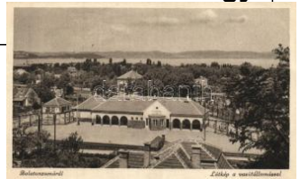
21625. ☒ Zámárd, vasútállomás (EK) T2/3 1600
