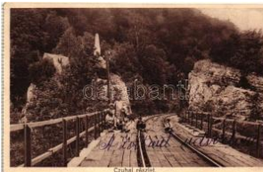
20543. ☒ Cuha-völgyi vasúti híd T2 2000
