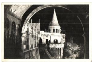
20363. ☒ Budapest I. Halás zbástya, éjjeli kivilágítá 1000
