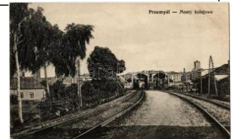
22777. ✳✳ Przemysl, Mosty kolejowy / railway bridge 2000
