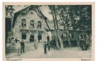
20831. ✱✱ Hévíz, Gyogyte rem (ázott / wet damag 1600
