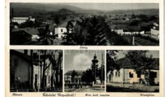
21585. 1943 Verpelét, Lá tkép, Vasútállomás, Ró 1600
