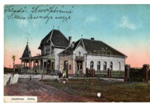
21292. * 1917 Siklós, Jaka bháza vasúti vendéglő. 3400
