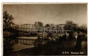
21798. ☒ 1941 Dés, Dej; Szamos híd, folyóparton 3000
