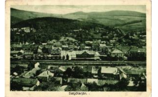
21253. ✱ Salgótarján, vasútállomás (fl) T2/3 2800
