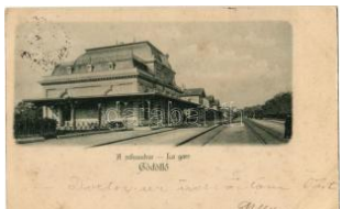
20731. ✉ 1899 Gödöllő, vasútállomás T2 1600
