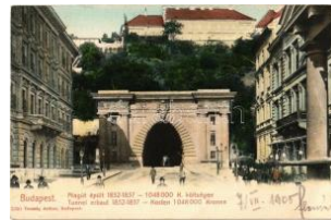
20353. ☒ 1905 Budapest I. Budai alagút, épült 185 1600
