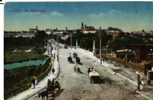
22776. ✳✳ Lublin, Ul. Zamojcka / street view, bridge 800
