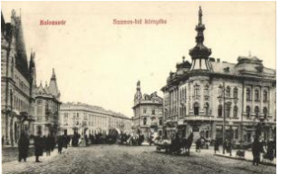
21981. ☒ 1908 Kolozsvár, Cluj; Szamos híd körny 2000
