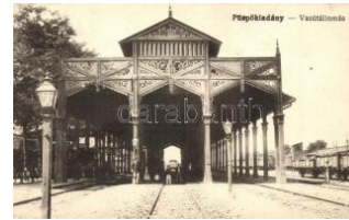
20946. Püspökladány, vasútállomás (Rb) T2/3 2800
