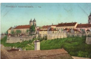
21164. ✉ Veszprém, vár (ázott / wet damage) T3 1000
