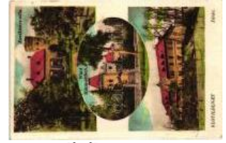
20934. Piliscsaba, Klot ildliget, Kacsokovics villa 1000
