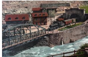
22341. ** Goeschenen, Gotthardbahn, tunnel T1 1400
