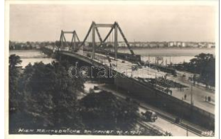
22088. * 1937 Vienna, Wien; Reichsbrücke eröffnet 2000
