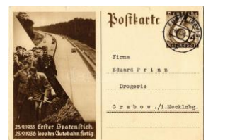
22738. ☒ 1933 Erster Spatenstich - 1936 1000 km 2600
