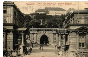
20310. ☒ 1908 Budapest I. Budai alagút, épült 185 1400
