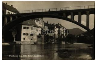
22104. ** Waidhofen an der Ybbs, Zeller Hochbrücke 1400
