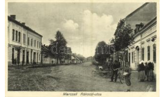
20793. ✱✱ Marcali, Rákóczi utca, Korona szálló T2 3000
