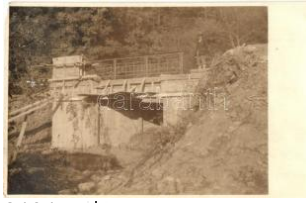
21014. ✱ Szarvaskő, híd építése. Dévényi Gusztáv 2200
