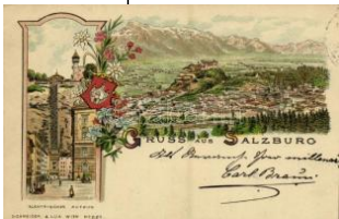
22058. 1898 Salzburg, Elektrischer Aufzug T2/31600
