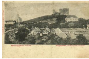
21588. ** Nagykövesd, Vekly Kamenec; Sát T2/3 1000
