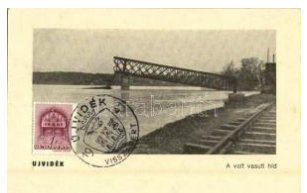
21924. ✨ Újvidék, Novi S ad; A volt vasúti híd / T1/2 1000
