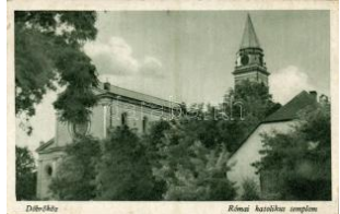
20471. Döbrököz, Római katolikus templom (R T3 1600
