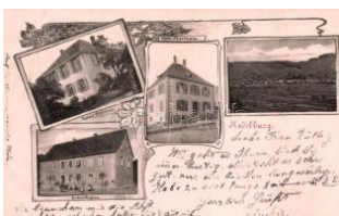
22374. Kadelburg, Schulhaus, Katholische un T2 4800
