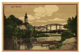
20584. 1924 Győr, Rába híd, csónakok a p T2/3 1400
