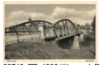
20749. ☒ 1936 Körmend, Rába híd T2 T2 1400
