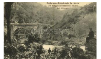
22277. * Altenahr, Hochwasser-Katastrophe im T2000
