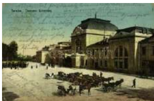
23579. Tarnów, Tarnau; Dworzec kolejowy T3/4 1000
