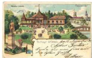
20936. 1899 Győr, Sétat- éri kiosk, Püspöki T2/3 3000
