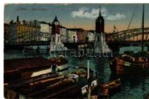
23576. Szczecin, Stettin; Hansabrücke / b T2/31400
