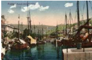
22954. ☒ Fiume, Canale de Ila Fiumara / port wit T3 1000
