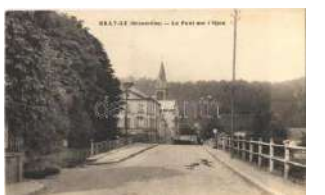
23482. Bray-et-Lu, Le Pont sur l'Epte / bridge T12000
