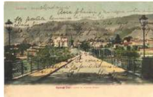
24032. * Caracas, Viaducto Union sobre la Av T2/3 2000
