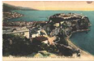
23592. ** Monaco, Vue g énérale de la Princ T2/32000
