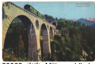
23362. ✱✱ Mittenwaldbahn (Karwendelbahn), V T3 1000
