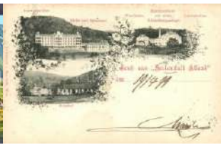
23315. ☒ 1899 Alland, Kran kenpavillon, Küche u T23800
