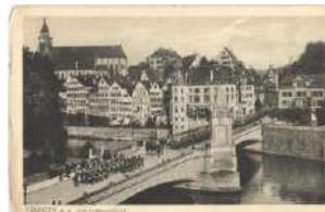
23724. ** Tübingen, Eberhardbrücke / bridge T2/32000
