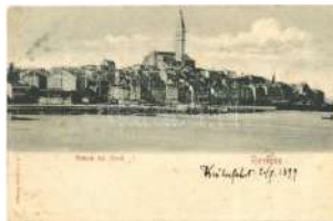
23035. 1899 Rovinj, Rovigno; Veduto dal Nor T2 1000
