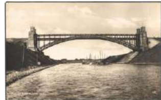
23677. ** Hochbrücke b. Levensau / Levensa T1 2000
