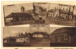
20860. ☒ Lőrinci, községháza, vasútállomás, H T2/32000
