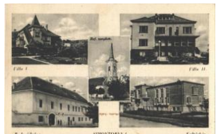
21152. ☒ 1942 Simontornya, Római katolikus is T21000
