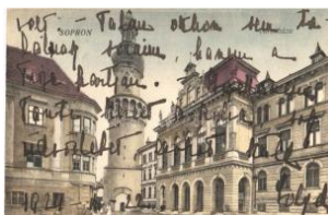
21184. ☒ Sopron, Városháza (Rb) T2/3 T2/3 1600
