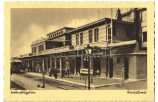
20792. 1941 Kiskunféleg yháza, vasútállomás T2 1000
