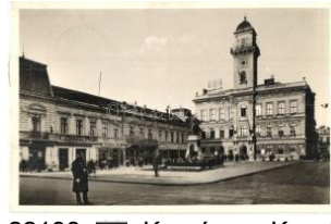
22198. ☒ Komárom, Komárnó; Városháza, Klap T21400
