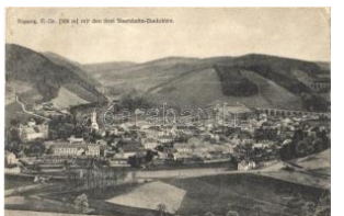
22763. ☒ Aspang, Drei Sta atsbahn-Viadukten T2/31000
