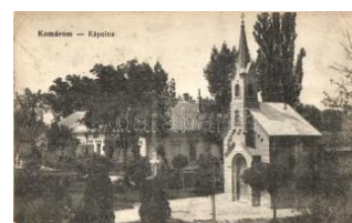
22182. Komárom, Komárom; Erzsébet szige T2/31400
