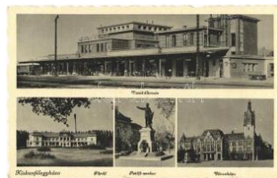
20801. 1942 Kiskunféleg yháza, Vasútállomás T21600
