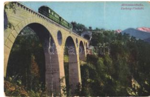
22813. ** Mittenwaldbahn (Karwendelbahn), V T3 1000
