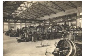
21018. ** Ózd, Gázgépek, belső munkások t T2/3 3800
