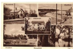
20511. ✱✱ Dunaalmás, vasútállomás, hajóállom T2 1600
