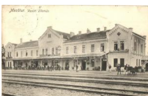
20907. ☒ 1913 Mezőtúr, Vasútállomás, létra, v T2/34000
