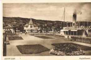
21111. ☒ 1948 Révfülöp, h a jóállomás, gőzhajó T12000
