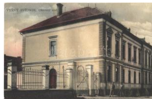
22082. Felsővízköz, Felső-Szvidnyik, Vysny S T3 1600
