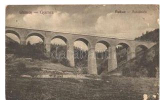
21500. ** Gyimes, Ghime s; Viadukt, vasúti h T2/3 1600
