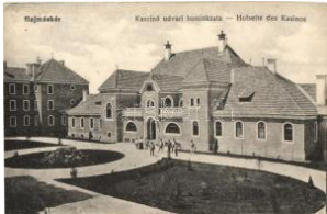
20741. ** Hajmáskér, Kaszínó udvari homlokza T21600
