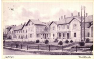
20688. * Gyékényes, vasúttállomás (Rb) T2/3 T2/3 2200
