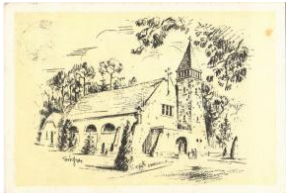
20233. 1935 Balatonfenyves, Építés alatt álló T2 2000
