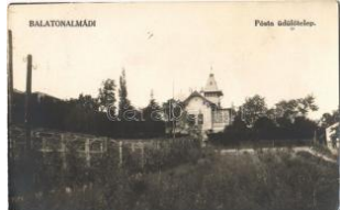
20222. ☒ 1941 Balatonalmádi, Posta üdülőtelp T2 2600
