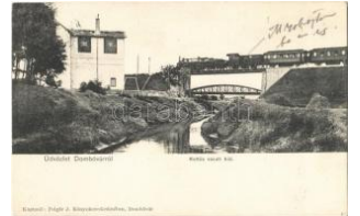
20584. ☒ 1907 Dombóvár, Kettős vasúti híd, gő T2 3800
