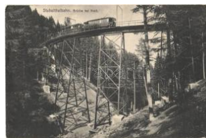
22207. Stubaitalbahn, Brücke bei Kreitz T2/32000
