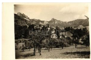
21590. ✱ Szulyóvályú, Szulyó, Súlov-Hradná; T2 2000
