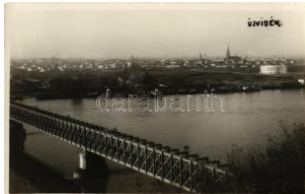
21817. ☒ 1941 Újvidék, No vi Sad; vasúti híd, lá T2 1400
