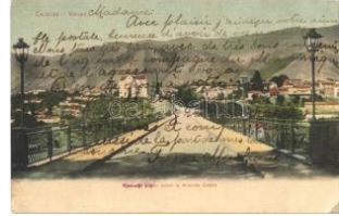
22379. * Caracas, Viaducto Union sobre la Av T2/3 2000
