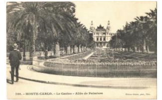
22019. ** Monte-Carlo, Le Casino, Allé de P T2/31600
