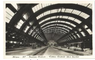
22171. ** Milano, Stazione Centrale, Tettoia T2/3 2000
