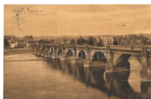
22078. 1910 Koblenz, Coblenz; Moselbrücke T1/22000
