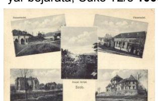
20893. ☒ Szob, Dunai távlat, híd, vasútállomás, T22400
