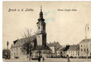
21830. ** Lajtabruck, Bru ck an der Leitha; F T2/3 3000
