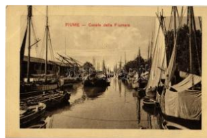
21746. ** Fiume, Rijeka; Canale della Fiumara T2 1400
