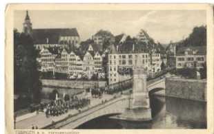
22125. ** Tübingen, Eber hardbrücke / bridge T2/32000
