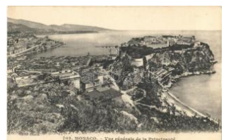
22015. ** Monaco, Vue générale de la Princ T1/21600
