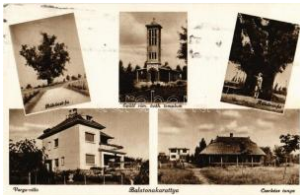
20176. Balatonakarattya, Rákóczi fa, épülő R T2 1600
