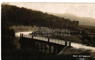
21004. ✱ Pilisszentkereszt, új hid. photo (EK) T3 1400
