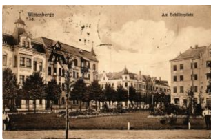
22732. 1923 Wittenberge , Am Schillerplatz / T2/3 1400
