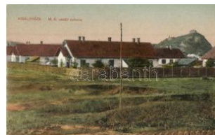
22171. ✱✱ Királyháza, Koroleve; MÁV vasúti ko T23200
