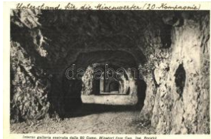
23398. * Interno galleria costruita dalla 20 Com T2/31000
