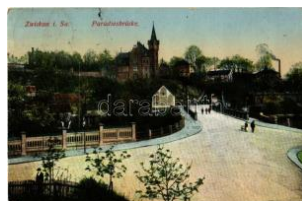
22734. 1921 Zwickau, Pa radiesbrücke / brid T2/3 1000
