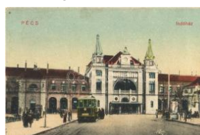
20979. ☒ 1925 Pécs, Indóház, Vasútállomás, T2/3 1800
