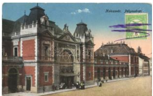
21417. 1914 Kolozsvár, Cluj; vasútállomás T2/3 1600
