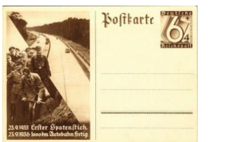
23008. ** 1933 Erster Spa tenstich - 1936 100 T2/32400
