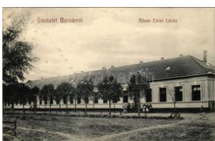
21888. ☒ 1913 Bocsár, Bocsar; Állami elemi iskol T2 2200
