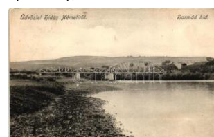
20639. ☒ Hidasnémeti, Herád vasúti híd, Skaln T32000
