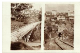
21658. ✱ Torna, Tarnova, Tarnova; viadukt, alagú T2 2800
