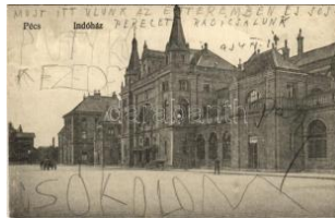
20925. ☒ 1934 Pécs, indóház, vasútállomás. Va T21400
