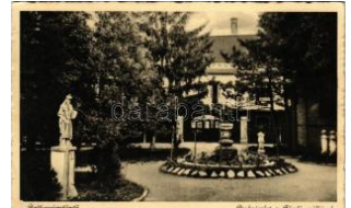
20203. 1936 Balf-gyógyfürdő (Sopron), par T2/3 1600
