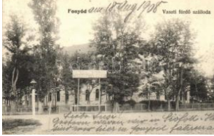
20572. ☒ Fonyód, Vasúti fűrdő szálloda, étterem T23000
