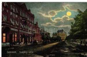
21118. ✱ 1915 Szolnok, Szapáry utca este, Nem T3000
