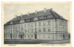
21754. ☒ Komárom, Komárom; M. kir. állami po T2 2000
