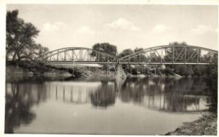
20991. Dés, Dej; Szamos híd / bridge T2 T2 1200
