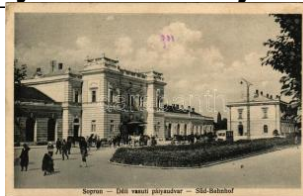
20797. ☒ Sopron, Déli vasúti pályaudvar, vasú T2/3 1200
