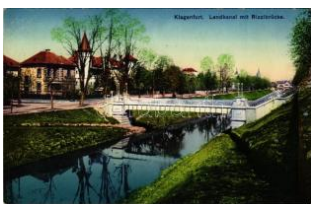
21615. Klagenfurt, Lenkkanal mit Rizzibrücke T1 1200
