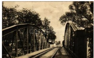
20776. ☒ 1927 Siófok, Vasúti híd és vasútállomás T2/3 1400
