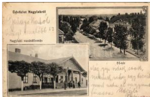
21077. ✳ Nagylak, Nadlac; vasútállomás, Fő tér T3 6000
