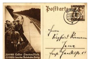
22799. ☒ 1933 Erster Spatenstich - 1936 1000 T4 1600
