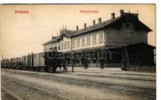
20354. ☒ 1908 Dombóvár, Vasútállomás, von T2/3 3400
