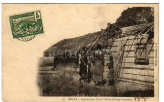
22118. ☒ 1904 Mpaka, Construction d'une Toit T2 3000
