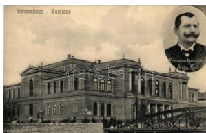
21952. ✳ Sarajevo, Vereinshaus Restaurateur S T23800
