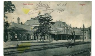
20329. ☒ 1911 Cegléd, Va sútállomás, létra. Ste T32400
