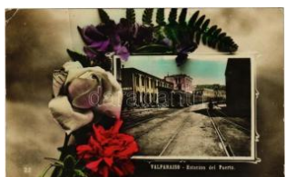
21958. ✳ 1910 Valparaíso, Estacion del Puerto T2/3 1600
