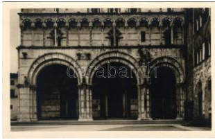
22362. * Lucca, S. Martino , La facciata / cath T2/3 1000
