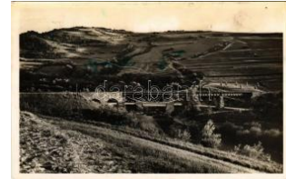
21657. 1941 Uzsok, Uzhok; viadukt, vasúti T2/3 2200
