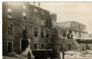
21995. * 1927 Rájec-Jestřebí, Demolierung de T2/36000
