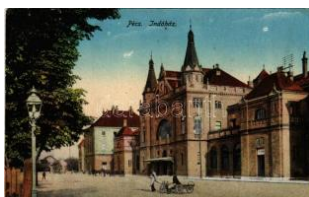
20743. Pécs, Indóház, vasútállomás. Hes T2/3 2800
