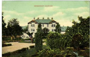
20539. ☒ 1909 Kecskemét , Indóház, vasútállom T22800
