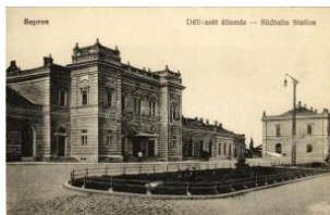
20812. ** Sopron, Déli vasút állomás, Győr-S T2/32800
