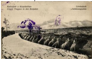
22834. ** Katonáink a Kárpátokban, lövészáro T2 2400
