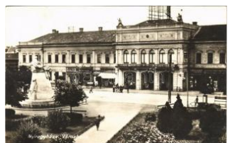
20973. ☒ 1930 Nyíregyháza, Városháza, Feu T2/3 1600
