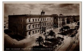
23028. ** Bari, Via Cavour, Palazzo delle Po T1/21000
