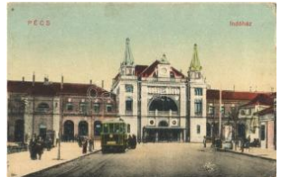
21030. ☒ 1925 Pécs, Indóház, Vasútállomás, T2/3 1800
