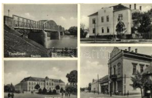
21248. 1936 Tiszafüred, Tisza-híd, Főszolga T2 2200
