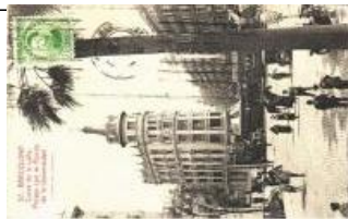
23290. Barcelona, Cruce de la calle Pelayo T2/3 1000
