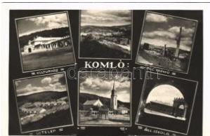
20798. ✱ Komló, Kultúrház, Villamos erőmű, ú T2/32400
