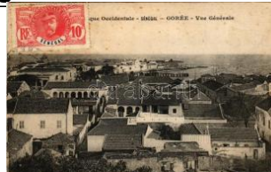
23419. 1910 Gorée, Vue Générale / genera T2/3 3000
