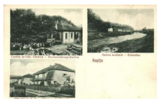
21545. ** 1928 Resica, Resita; Cantina de Fa T2 3000
