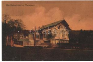
22374. Wienerwald, Die Rohrerhütte / rest ho T21000
