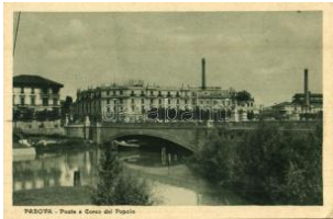
23137. ** Padova, Ponte e Corso del Popolo / b T2800
