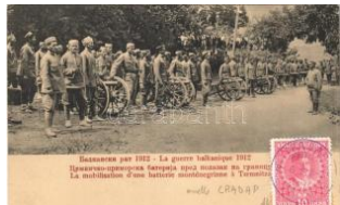
22685. * La mobilisation d'une batterie montée T2/31600
