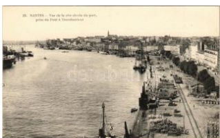
22216. ✨✨ Nantes, Vue de la rive droite du port T2 1600
