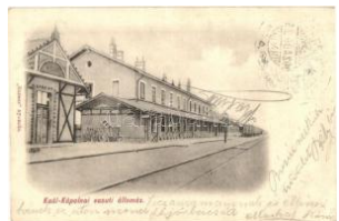
20758. ☒ 1902 Kál, Kaál; K ál-Kápolna vasútálló T2 3800
