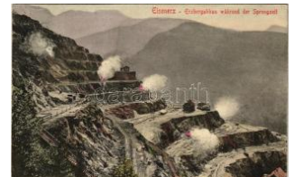
22099. * Eisenerz, Erzberg abbau während de T1/2 3000
