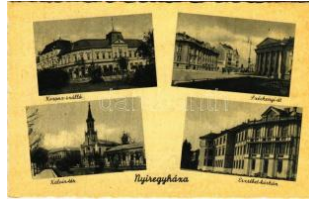
20917. ** Nyíregyháza, Kálmán tér, Korona sz T1/21000
