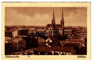
20260. ✨✨ Békéscsaba (ázott / wet damage) T T2/31000
