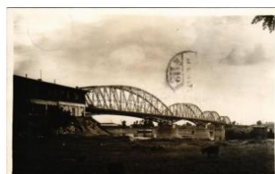
21610. ☒ 1939 Komárom, Komárno; híd / bridge T2 1000
