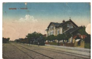
21244. ✱✱ Ipolyság, S ahy; Indóház, vasútállom T34400
