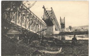
22350. * Die Eisenbahnbrücke Semlin-Belgrad. T2 1800
