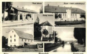
20554. ☒ Magyarbóly, Vasútállomás, Óvoda a T2/32000
