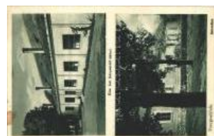
20633. ☒ 1943 Nyergesújfalu, Római katolikus le T21800
