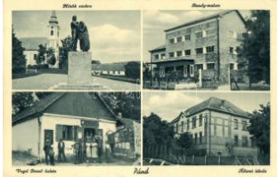
20658. ☒ Pánd, Hősök sz obra, Bundy malom T2/3 2200
