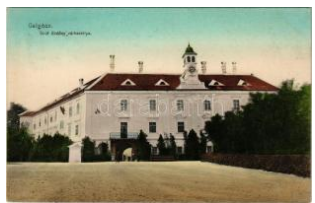
21235. ☒ 1912 Galgóc, Hlohovec; Gróf Erdődy v T22800
