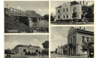
20841. ☒ 1936 Tiszafüred, Tisza-híd, Főszolga T2 2000
