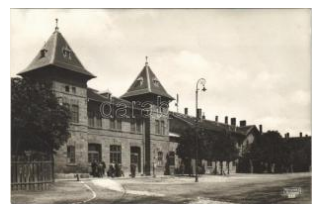
20289. Celldömölk, Vasúti indóház, vasútáll T2/3 3600
