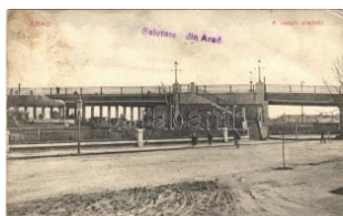
21412. * 1923 Arad, Vasúti viadukt, gőzmozdon T35500
