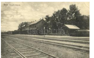
20114. ☒ Baja, Vasútállomás, vonat. Wurmfe T2/3 5500
