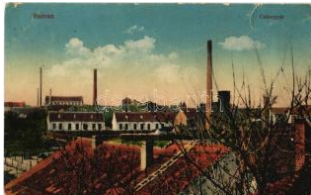
20690. 1916 Hatvan, cukorgyár. Vasúti leve T2/32000
