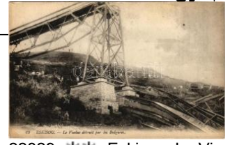
22829. ** Eskisou, Le Viaduc détruit par les T2/3 1600
