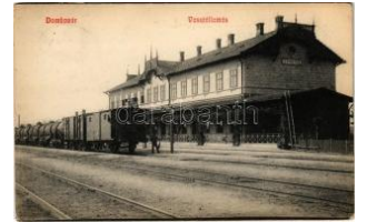
20505. ☒ 1908 Dombóvár, Vasútállomás, von T2/3 3400
