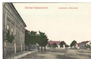
20680. ** Hajdúszovát, ut ca, Piac tér. Fogasz T2 4400
