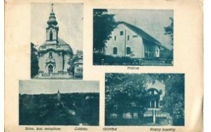
20615. ** Gomba, Római katolikus templom T2/3 1600
