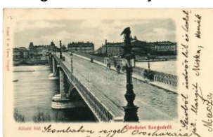
21218. 1899 Szeged, Kőzúti híd, építkezés. T2/32200
