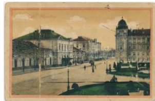
20656. ** Győr, Pályaudv ar, vasútállomás. lep T3 1000
