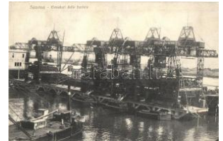
22541. ** Savona, Elevatori delle funivie / elev T22400
