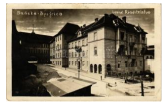
21793. * Besztercebánya, Banská Bystrica; Les T21400
