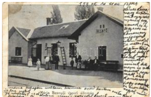
20883. 1920 Máriaesnyő (Gö döllő), Vasútállomás T3 3800
