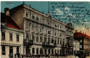
21166. 1936 Sopron, Pannonia szálloda, kávéház T2 2800
