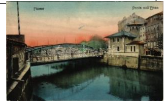
22061. Fiume, Rijeka; Ponte sull'Eneo / bridge T22400
