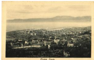
22062. 1912 Fiume, Rijeka; Totale / general v T21400
