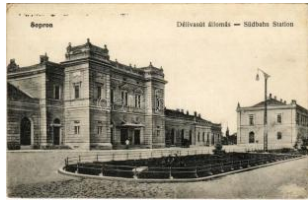
21151. ** Sopron, Déli vasútállomás T2/3 T2/3 2800
