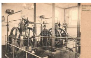
21820. Komárom, Komárom; Vízmű belső T118000
