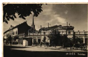
21495. * 1943 Dés, Dej; Színház, dohányárud T2/3 1600
