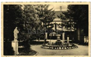
20190. 1936 Balf-gyógyfürdő (Sopron), par T2/3 1000
