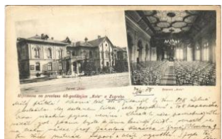
22375. ☒ Zagreb, Zág ráb; Zgrada Kola, Dvoran T24000
