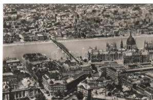
20235. * Budapest, Kossuth híd, Országház, T2/3 3000
