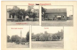
22399. Ernőháza, Torn a-Ernesztháza, Ban T112000
