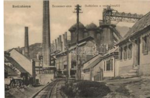
21352. ** Resicabánya, Resita; Bessemer utca T13200
