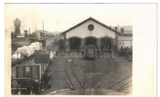
20433. ☒ 1942 Debrecen, vasszállomás, víztoron T22000
