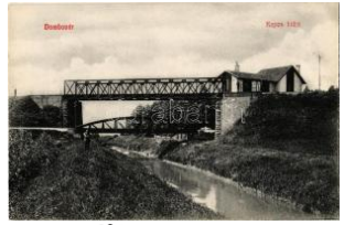
20451. Dombóvár, Kaposkötő vasúti hídja, kő T13800
