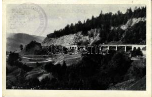
22114. * Uzsok, Uzhok; vasúti híd, viaduk T2/3 1600
