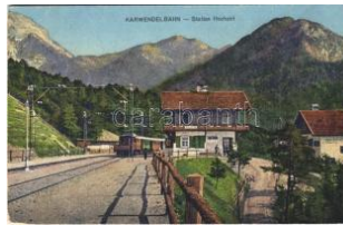
22563. 1925 Karwendelbahn, Station Hochz T2/3 3000
