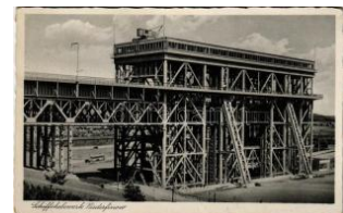
23061. * Niederfinow, Schiffsbauwerk / boat T2/3 1600
