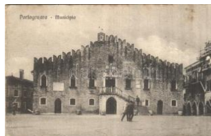
23188. ** Portogruaro, Municipio / town hall ( T2/3 1000
