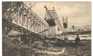
23870. * Die Eisenbahnbrücke Semlin-Belgrad. T2 2000
