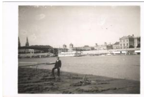
20865. * Szeged, híd, Kultúrpalota. photo T1/2 T1/2 1600
