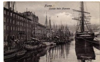
22245. ✖✖ Fiume, Canale della Fiumara, ship T2/31200
