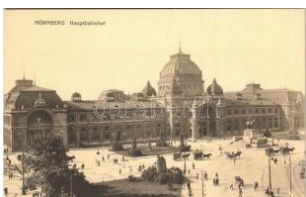
23062. ** Nürnberg, Nürnberg; Hauptbahn T2/32000
