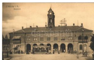
23027. ** Freiburg im Breisgau, Bahnhof / railw T2000
