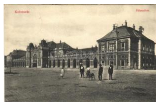
21172. ☒ 1914 Kolozsvár, Cluj; vasútállomás / T2 2400
