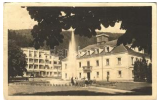
21895. ☒ Trencséntepic, Trencianske Teplice T3/4 1600
