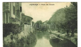
23156. 1908 Aquileia, Parte del Canale / ca T2/3 5500
