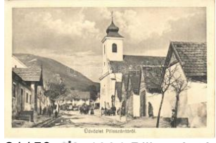
21150. * 1931 Pilisszántó, Fő utca, templom, T2/3 5500
