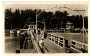
20186. 1931 Balatonalmádi, Hajóállomás T2 T2 1800
