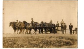
23364. ** Vidéki földút ép ítésének kivitelezése T22000
