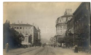
22512. ✱ 1916 Fiume, Rijeka; utcakép, villamoss T22400
