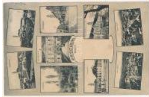
22722. 1910 Herzogenburg, Gesamtansicht T2/3 2400
