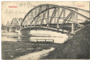
20761. ☒ 1909 Gyékényes , Dráva híd. Kiadja T2/3 2400
