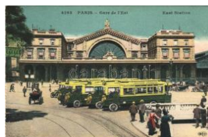
22927. ** Paris, Gare de l'Est / East Station, T2/32000
