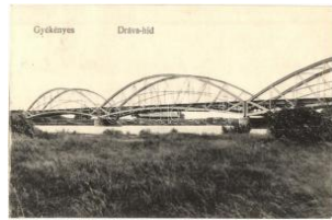
20763. ☒ Gyékényes, Dráv a híd T2 1800
