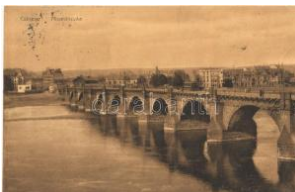
23097. 1910 Koblenz, Coblenz; Moselbrücke T1/22000
