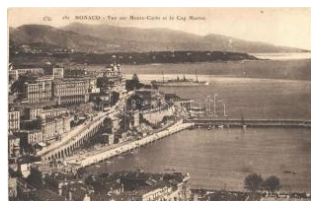
23015. ** Monaco, Vue sur Monte-Carlo et le C T21600
