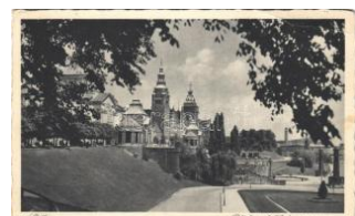
22996. * Szczecin, Stettin; Blick auf Hakerterra T31000
