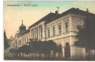
20928. ☒ Kisújszállás, Városi vigadó. Vasúti leve T2 2400
