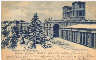
23137. 1899 Potsdam, Orangerie-Gebäude T2/3 1600
