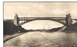
23092. ** Hochbrücke b. Levensau / Levensau T1 2000
