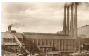
20715. ** Felsőgalla (Tatabánya), Cementgy T1/2 3200
