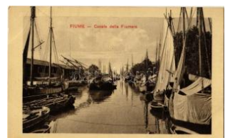
22508. ✱✱ Fiume, Rijeka; Canale della Fiumara T2 1400
