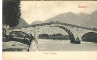
23195. ** Morbegno, Ponte di Ganda / bridge T2 1600
