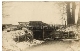
23718. A felrobbantott kő a híd provizori kő T2/3 1200
