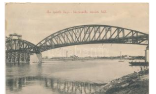
20138. B 1908 Baja-Bátaszék, épülő vasúti híd T2/31800
