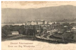
22541. ☒ Fehértemplom, Bela Crkva; vasútállom T3 2000
