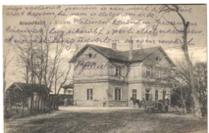
20111. * 1923 Almásfüzitő , vasútállomás, lov T2/32800
