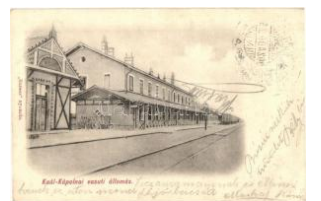
20882. ☒ 1902 Kál, Kál; Kál-Kápolna vasútállomás T2 3800
