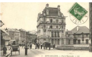
23037. Rive-de-Gier, Pont d'Egarande / bridge T21600
