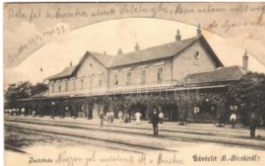
20453. ☒ 1901 Bicske, indóház, vasútállomás. T2/3 6000
