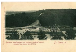
23043. Saint-Cloud, Parterre, emplacement T12000
