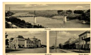
21568. ☒ Szolnok, Tisza híd, Városi színház, va T21400
