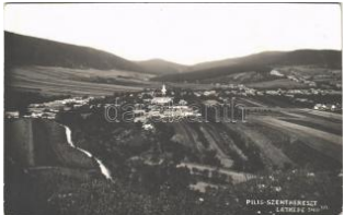
21393. 1935 Pilisszentkereszt, látkép. photo T 21800
