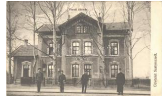
21496. Szatymaz, Vasútállomás, vasutasok. T2/3 7000
