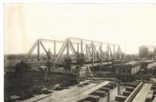
21119. * Kál (Heves), vasúti hid építése, vona T1/22800
