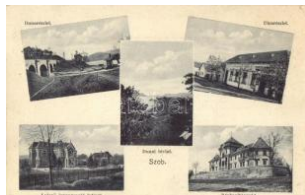
21562. ☒ Szob, Dunai távlat, híd, vasútállomás, T22200
