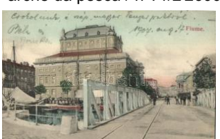
22501. ☒ Fiume, Vasútvonal, hid, kikötő / railw T2/3000
