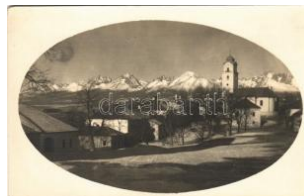
22286. * Strážsa, Stráže p od Tatrami (Poprád) T2/3 1600
