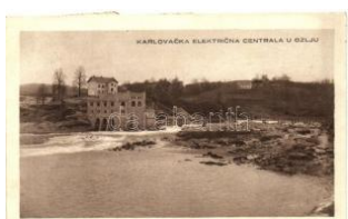
22533. * Ozalj, Karlovacka Elektricna Centrala T3 2000
