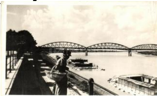
22635. ☒ Zenta, Tisza-híd / bridge (fa) T4 T4 1000
