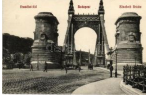
20686. ✱✱ Budapest IX. Erzsébet híd pesti hídfő T1 2800
