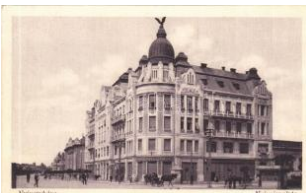
21444. ✉ 1929 Nyíregyháza, Nyírvízpalota T2 T2 1800
