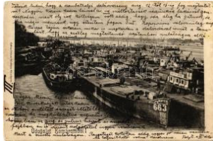
22585. ☒ 1905 Komárom, Komárom; Téli kikötő T2/31400
