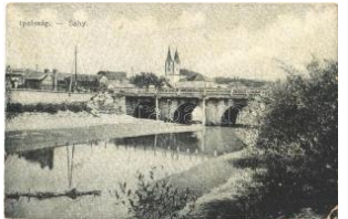
22512. * 1925 Ipolyság, Sah y; híd / bridge (EK T2/31200
