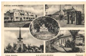
21946. * Zamárdi, Balatonzamárdi; vasútállom T2/31200
