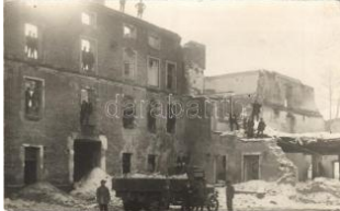
23308. * 1927 Rájec-Jestřebí, Demolierung de T2/3 1800
