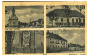
21446. ✱ Nyúl, Római katolikus templom és isko T31400
