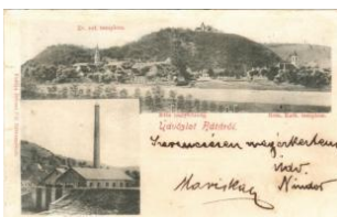
20360. ☒ 1905 Bata, Szivattyú-telep, Reformátu T46000
