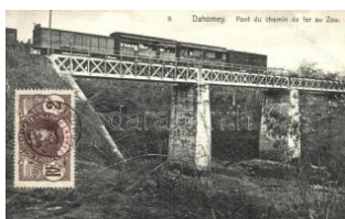
22163. Dahomey, Pont du chemin de fer au T1/23000
