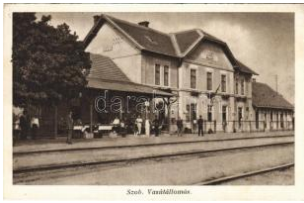
21029. 1933 Szob, vasúttállomás (EK) T2/3 T2/3 1800
