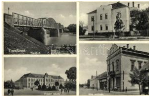
21096. ☒ 1936 Tiszafüred, Tisza-híd, Főszolga T2 1800
