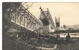
23228. * Die Eisenbahnbrücke Semlin-Belgrad. T2 1600
