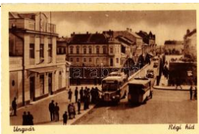
21794. ** Ungvár, Uzshorod, Uzshorod; Régi híd, T21200
