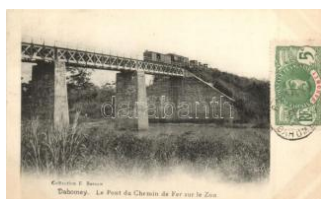
22162. Dahomey, Le pont du chemin de fer T1/23000
