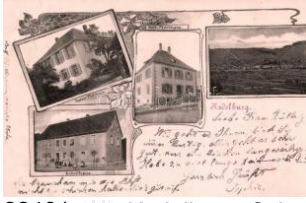
22481. Kadelburg, Schulhaus, Katholische un T24800
