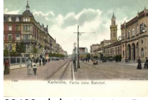
22483. Karlsruhe, Parte beim Bahnhof / b T1/22400
