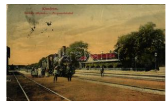
21600. ☒ 1916 Komárom, K omárno; Vasútállom T2/4400
