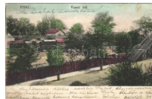
21407. 1914 Pisk, Simeria; Vasúti híd, vasút T3 4800
