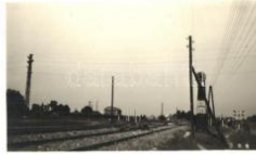
20513. ** Eger, Vasútállomás, baleset, elütrött T2 2000
