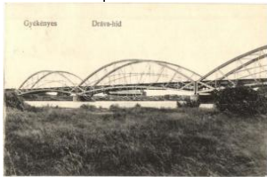
20576. ☒ Gyékényes, Dráva-híd T2 T2 1800
