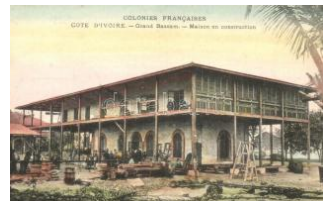
22280. Grand-Bassam , Maison en construc T14000
