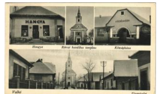
20965. * Valkó, Római katolikus templom, Köz T2/3 1600
