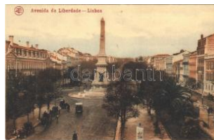
22316. ** Lisboa, Lisbon; Avenida da Liberdade T2 2000
