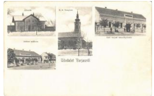
21279. ** Varjas, Varias; vasútállomás, Róma T2 2000
