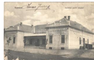
20205. ☒ 1906 Balatonszemes, Szemes; Bala T3/43200
