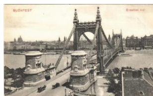
20236. Budapest, Erzsébet híd budai hídfő T1 1400
