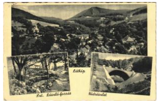
20747. 1943 Pilisszentlélek (Esztergom), híd T2 1400
