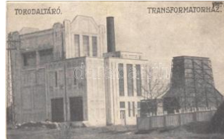
20951. ☒ Tokodaltáró, Transzfórmátorház (EB T2/3 4200
