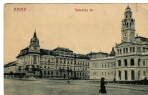
21004. ☒ 1910 Arad, Városház tér, Városháza. T4 1600
