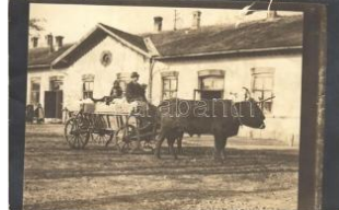
21757. * Tiszaújlak, Vulok, Vilok, Vylok; vasú T2/3 6000
