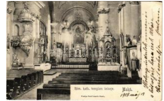
21090. 1908 Makó, Római katolikus templom T2/3 2000
