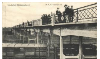
20370. ** Békéscsaba, M. AV Vasbeton vasúti T1 7000
