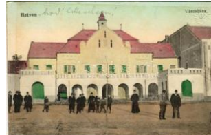
20898. ✱ Hatvan, Városháza. Vasúti levelező T2/31800
