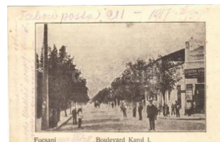
23126. 1917 Focsani, Fokszány; Boulevard K T2/31800
