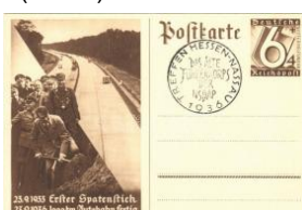
24016. ** 1933 Erster Spa tenstich - 1936 100 T2/3200
