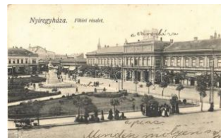
21206. ☒ 1915 Nyíregyháza, a, Fő tér, Városháza T2 2600
