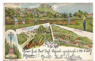
22885. 1898 (Vorläufer) Doboj, Bahnhof, S T2/310000
