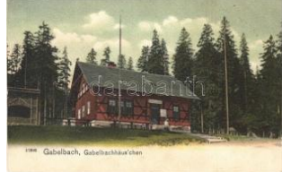
23004. * Gabelbach (Ilmenau), Gabelbachhütte T2/32000
