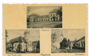
21860. ** Nagykároly, Carei; vasútállomás, Gr T4 1600
