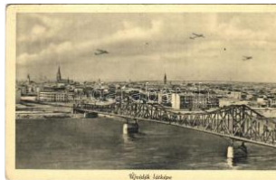
22749. 1943 Újvidék, Novi Sad; híd repülőg T2/3 1000
