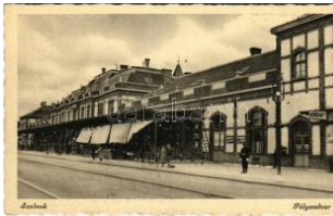
21475. Szolnok, pályaudvar, vasútállomás, kim T2 2600
