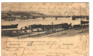
20428. ☒ 1899 (Vorläufer) Budapest, Margit híd T2 3200
