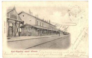
20960. ☒ 1902 Kál, Kaál; Kál-Kápolna vasútálló T2 3800
