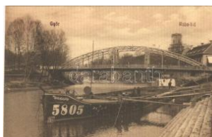
20877. ** Győr, Rába híd, uszály T1 T1 3600
