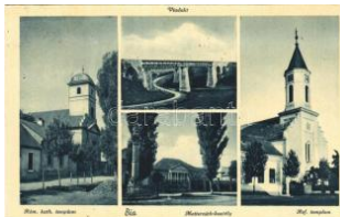
20380. 1942 Bia (Biatorbágy), Viadukt, Róma T2 1800
