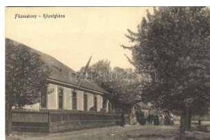
20837. * Füzesabony, Községháza, Vasúti leve T2 2400
