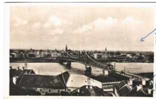
22748. 1943 Újvidék, Novi Sad; vasúti híd / ra T2 1000
