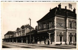
21668. ☒ 1943 Kolozsvár, Cluj; vasútállomás T2/3 3000
