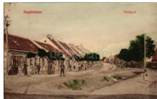
21063. ** Nagykanizsa, Teleki út, Ma T2 4400
