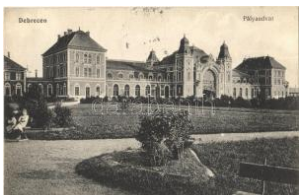
20684. ☒ 1913 Debrecen, Áltáudvar, vasútállom T3000
