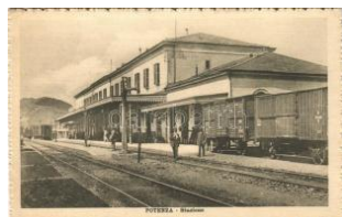
22666. Potenza, Stazione / railway station T2/3 4200
