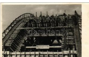
20818. * 1954 Hajdúszoboszló, vasbeton híd T2/3 4600
