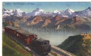
22769. ☒ 1930 Rigibahn, Rigibahn und di T3 1000
