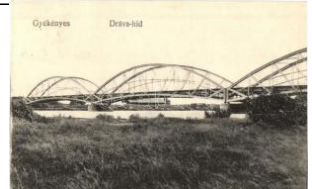
20795. 1923 Gyékényes, Dráva híd T2 1800
