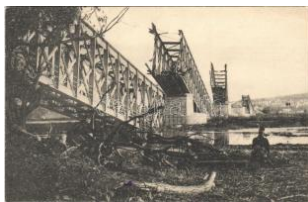
23285. * Die Eisenbahnbrücke Semlin-Belgrad. T2 1600
