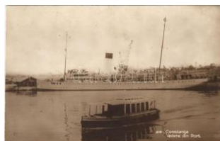
22729. ✉ 1935 Constanta, Vedere din Port / por T22200
