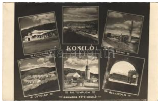
20946. ☒ Komló, Kultúrház, Villamos erőmű, Ú T2/3 1600
