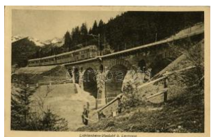
22357. * 1919 Lermoos, Lichtenberg-Viadukt T2/3 2000
