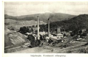
21230. ☒ 1935 Salgótarján, Vízválasztó villany T2 1800
