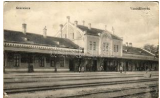
21397. * Szerencs, vasúti illozás. Vasúti levele T3 3600
