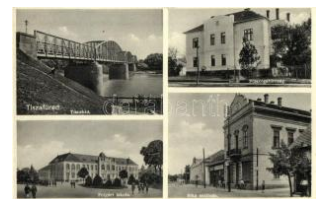
21483. 1936 Tiszafüred, Tisza-híd, Főszolga T2 1800
