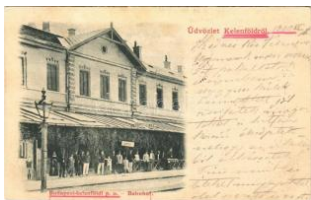
20561. 1900 Budapest X. I. Kelenföldi vasútá T2/38000
