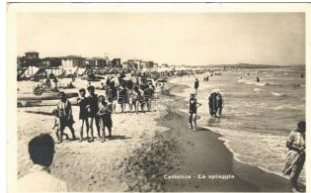
22645. ** Cattolica, La spiaggia / beach, bathhouse T31600
