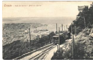
22680. * 1907 Trieste, Trst ; Ferrovia elettrica T2/3 1600
