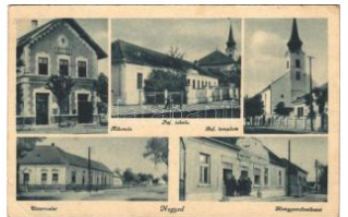
22011. ✱✱ Negyed, Neded; Vasútállomás, Re T2/32600
