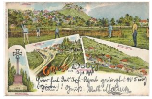
22493. 1898 (Vorläufer) Doboj, Bahnhof, S T2/310000
