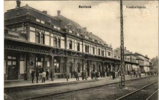
21345. 1914 Szolnok, Vasútállomás. Gerő I T2/3 3400
