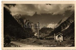
22429. ** Plöckenstrasse mit Kellerwand und T2 1600
