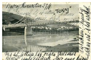
21413. ☐ 1903 Tokaj, híd (szakadás / tear) T3 T3 1600
