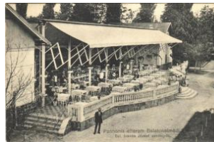
20205. 1930 Balatonalmádi, Pannónia étterem, T23800
