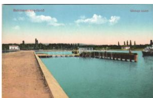
20263. ✱✱ Balatonszemes, Szemes; Gózhajó T1/22400
