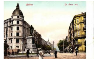
22766. ** Bilbao, La Gran Via / main boulevard T41000
