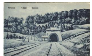
22107. Orsova, vasúti a lagút / railway tunn T2/3 4200
