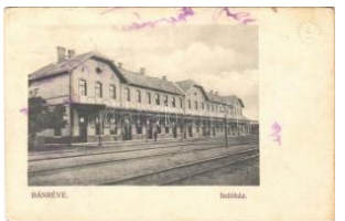
20312. 1919 Bánréve, indóház, vasútállomás T2/3 2000
