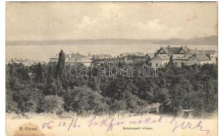
20234. 1905 Balatonfüred, Balaton-parti villas T3 3800
