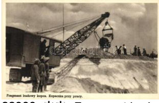
22988. ** Fragment budowy kopca. Kopaczka przy pracy. T1 1400
