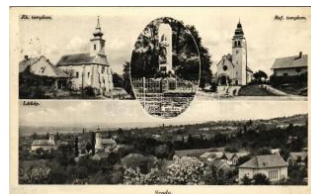
21507. ☒ 1940 Szada, Római katolikus templom T2/3 2600
