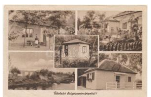
21631. ☒ 1944 Szigetszentmárton, nyaraló villa T41600
