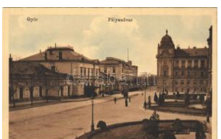
20828. ** Győr, Pályaudvar, vasútállomás T2 T2 2400
