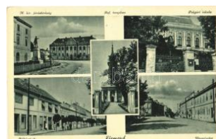
21087. ** Körmend, M. kir. Járásbíróház, Refo T21200
