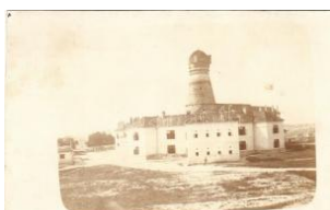
21490. ** Sopron, Szélmalom kaszárnya, lak T2/3 4200
