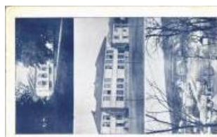
20351. * Bocsárdlapujtó (Karanclapujtó), Moc T2/3 4400
