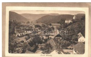
21477. * Sirok, látkép (ázt t / wet damage) T4 T4 1000
