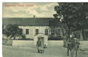
21246. ☒ Nagyvisnyó (Héves), községi iskola T2/3 2000
