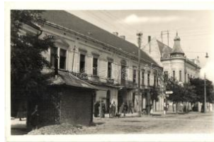
22173. ✳✳ Szinérváralja, Seini; Piaț tér, Korona T11800
