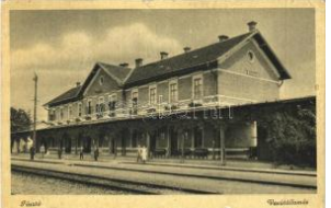
21320. ☒ Pásztó, vasútállomás (kis szakadások T32200
