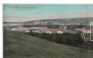
23065. 1908 Cernavoda, Cerna Voda; Ved T2/312000
