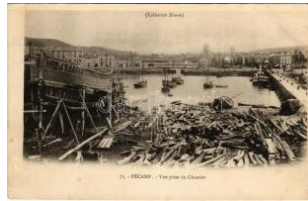
22921. * Fécamp, Vue prise du Chantier / vie T2/3 1000
