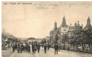
22192. ☒ Igló, Iglau, Spišská Nová Ves; Vigad T2/32000
