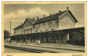
21265. Pásztó, vasútállomás (kis szakadások) T3 2200
