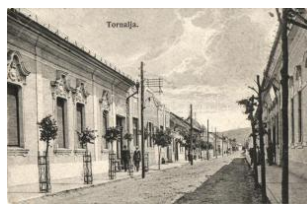
22554. * Tornaalja, Tornaalja; utcakép / street view T2/3 2600
