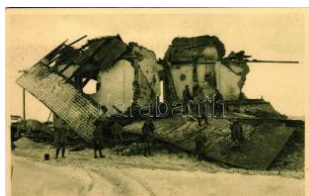
23762. ** Zerstörtes Haus an der Strypa 191 T1/2 1000
