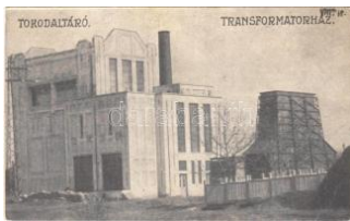
21572. ☒ Tokodaltáró, Tra nszformátorház (E T2/3 4200
