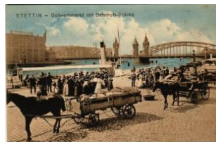
22946. * Szczecin, Stettin; Bollwerkmarkt mit B T1 4000
