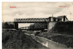
20694. * Dombóvár, Kaposkötő vasúti hídja, kő T13800
