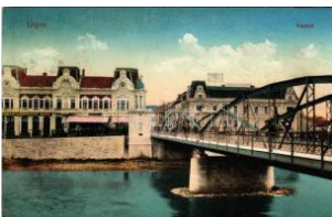
21816. ☒ 1913 Lugos, Lugoj; vas híd, Délmag T2/32400
