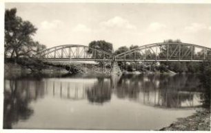
21732. ☒ Dés, Dej; Szamos híd / bridge T2 T2 1200
