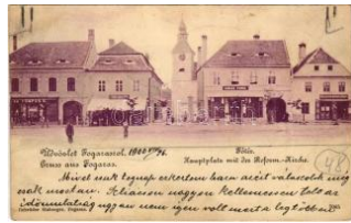
21765. * 1900 Fogaras, Fogaras; Fő tér, Reform T3500
