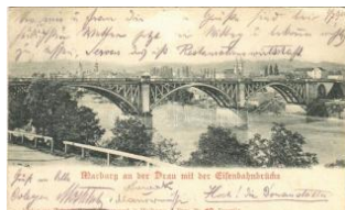
23101. ☒ 1901 Maribor, Ma rburg; Eisenbahnbruc T3 4200
