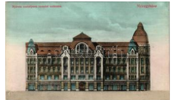
21190. ** Nyíregyháza, Nyírvíz Szabályozó T1/2 3200
