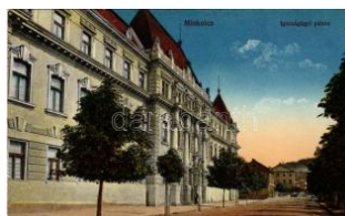
21116. ** Miskolc, Igazságügyi palota. Vasúti T1 1000
