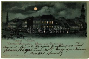
21343. * 1899 (Vorläufer) Sopron, Várkerület, P T 31000
