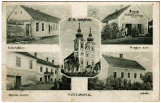
21159. 1903 Nagykopornak, Iskola, Községháza, T2/3 1600
