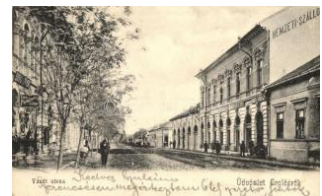
20570. ☒ 1905 Cegléd, Vasút utca, Nemzeti sz T2 3400
