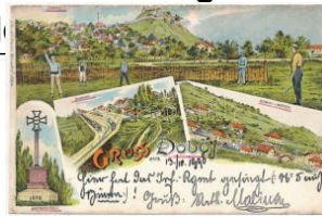
22849. 1898 (Vorläufer) Doboj, Bahnhof, S T2/310000
