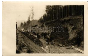
23376. ** Tábori vasút építése (?) / military f T2/3 3000
