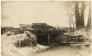
23339. * A felrobbantott lkv a híd provizórikus T2/3 1200
