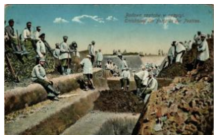
23388. ** Budowa szancon w w pozycji / Erricht T2 2600
