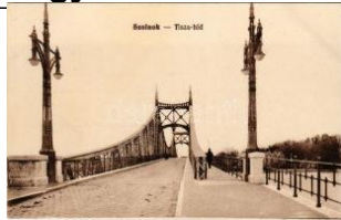
21504. ** Szolnok, Tisza híd T1 T1 1200
