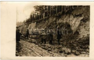
23375. ** Tábori vasút építése (?) / military f T2/3 3000
