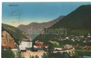
23139. Zidani Most, Stei nrbuck; Bahnhof / ra T2 1400
