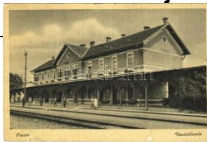
21501. ☒ Pásztó, vasútállomás (kis szakadások T32200
