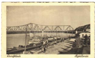
20948. 1938 Dunaföldvár, Hajóállomás, híd T2/3 2600
