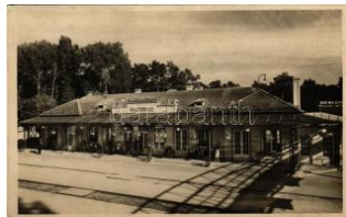
20253. ☒ Balatonszemes, vasútállomás, Meinel G T23000
