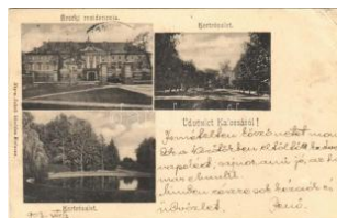
21198. ☒ 1903 Kalocsa, Ér seki rezidencia, kert. T3 3200
