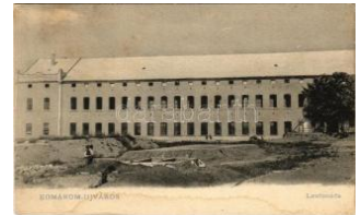
22579. ✱✱ Komárom, Komárom; Komárom-Uj T2/3 4400
