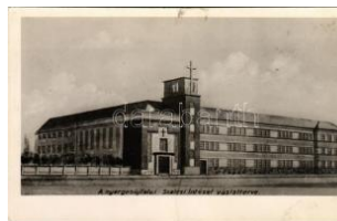
21458. ✨ 1943 Nyergesújfalu, Szalézi Intézet T2/3 2400
