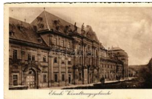
24019. ☒ 1923 Ebrach, Ve rwaltungsgebäude T2/3 1000
