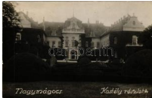
21597. ☒ 1947 Nagymágocs, Károlyi kastély. p T2/3 1400
