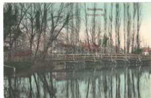
21137. 1908 Jászberény, Városligeti híd. Hul T2 2600
