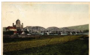
23111. ☒ 1936 Párkány, Stúrovo; híd / bridge (fa) T 3900
