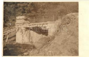
21917. ✳ Szarvaskő, híd építése. Dévényi Gusztáv 1800
