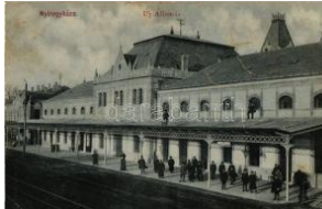
21621. ☒ 1910 Nyíregyháza, új vasútállomás, T2/3 2400
