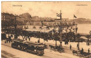
24029. ** Hamburg, Alste r-Pavillon / restauran T2 1000
