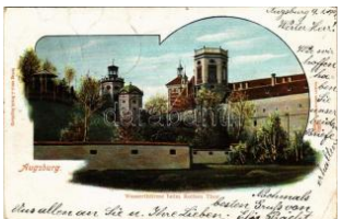
24005. ☒ 1901 Augsburg, W assertürme beim R T2/31600
