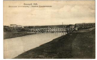
23976. 1915 Przemysl, Zniszczony most ko T3 1400
