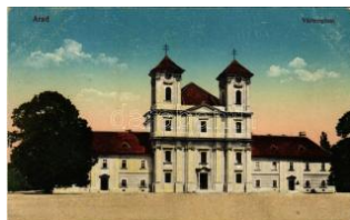
22289. 1916 Arad, Vártemplom. Vasúti leve T2/32800
