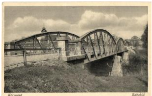
21312. 1936 Körmend, Rába híd T2 T2 1400
