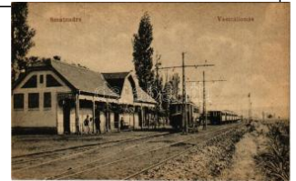
22003. ** Szentendre, HéV vasútállomás, von T1 2800
