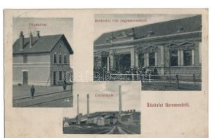
20422. 1911 Beremend, pályaudvar, vasúti T2/3 1200
