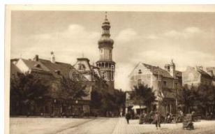
21907. ☒ Sopron, Várostorony, Gruber Dávid út T2 1400
