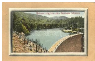
22342. ✱✱ Brázova, Breazova; Völgyzáró-gát T2/3 3400
