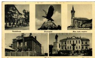
20396. Bánhida (Tatabánya), Vasútállomás, T2/3 1600
