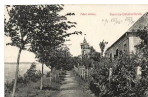
20383. ☒ Balatonszemesfürdő, Felső sétány T2/3 5500
