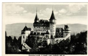
22655. ✉ 1939 Bajmóc, Bojnice; Bojnicky hrad v T21600
