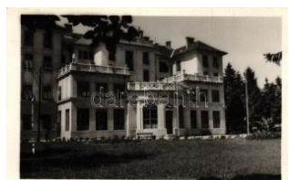
20287. Balatonföldvár, Kupavezer szálló T2/3 1600
