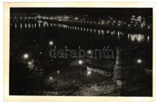
20493. Budapest, Erzsébet híd építés közb T1 2800
