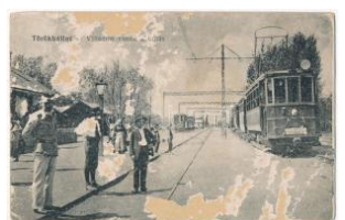
22179. Törökbálint, Villamos vasúti végállomás T41000
