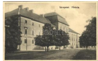
21813. ☒ 1929 Sárospatak, főiskola + "SÁTORA T2 2000
