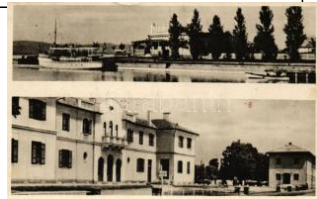
20267. Balatonboglár, hajóállomás, vasútáll T2/3 T2/3 1600
