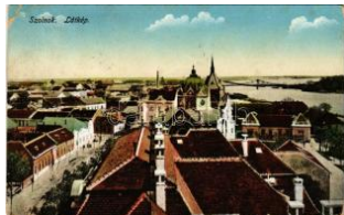
22066. ☒ 1916 Szolnok, zsinagó (szakadás / T31000
