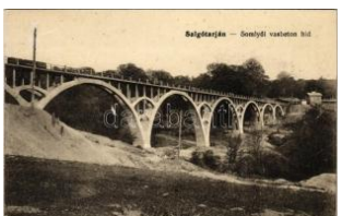
21794. ✱✱ Salgótarján, Szmlyói vasbeton híd, v T2 2000
