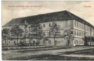
21255. ☒ 1915 Kalocsa, Nagyobb papnevelde a T2 2600
