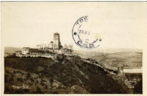
22337. * Trencsén, Trencín; vár / Trenciansky T2/3 1600
