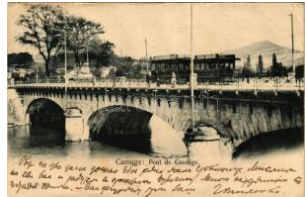
23232. 1905 Carouge, Pont de Carouge / b T2/3 3600
