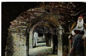
21503. ☒ 1915 Ada Kaleh, sírcsarnok, katakó T2/37000
