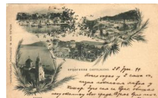
23109. ☒ 1899 (Vorläufer) Herceg Novi, Casteln T22000
