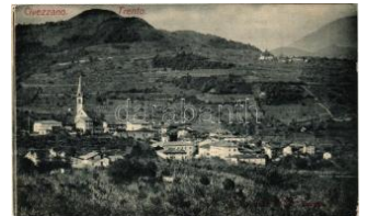
23149. 1905 Civezzano (Südtirol); general T2/3 2000
