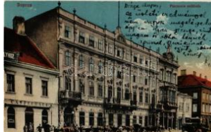
21251. 1936 Sopron, Pannonia szálloda, kávéház T2 2600
