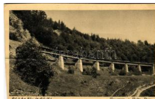
22485. ** Uzso, Uzok, Uzok, Uzhor; viadukt, vasúti T4 1200
