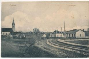
22810. * Felsőőr, Oberwar t; Villanymű. Blasy T3 12000
