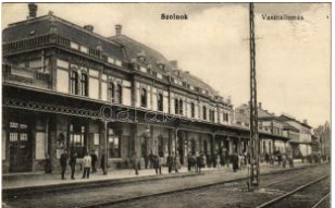
21377. ☒ 1914 Szolnok, Vasútállomás. Gerő I T2/3 3400
