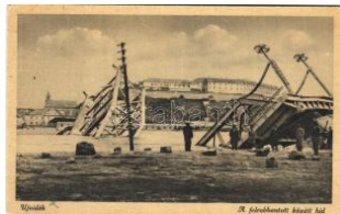
22786. ** Újvidék, Novi Sad; a felrobbantott kő T21200
