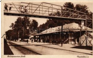
20342. ☒ Balatonszemes-fürdő, vasútállomás T2/33000
