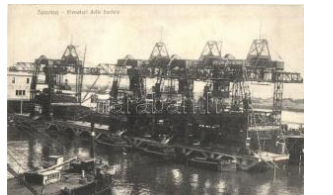
23173. ** Savona, Elevatori delle funivie / elev T21800
