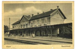
21167. Pásztó, vasútállomás (kis szakadások) T3 2200
