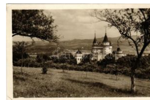
21960. ** Bajmóc, Bojnice; Bojnicky zámok / T2/3 1600
