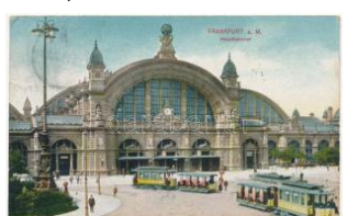
23124. ☒ 1908 Frankfurt a. Main, Hauptbahnh T2/31000
