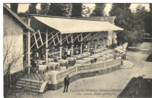
20310. * 1930 Balatonalmádi, Pannónia étterem T23800
