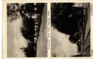
21344. ☒ Óreglak, utca, római katolikus templom T2/3 5500
