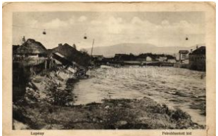
22031. ☒ Lupény, Felrobba ntott híd / blown-up T2/33600
