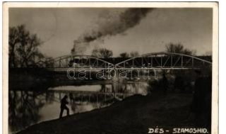
21908. 1940 Dés, Dej; Szamos vasúti híd, g T2/3 6000
