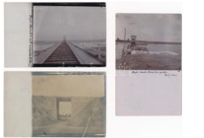
20229. ☒ 1908-1909 Baja, Dunai vasúti híd építé 20000
