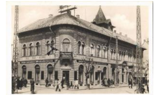
20770. 1942 Cegléd, Ke reskedelmi Bank székhelye T2 1800
