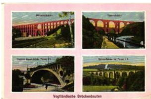
23228. ** Vogtland, Brückenbauten; Göltzsch T2/31600
