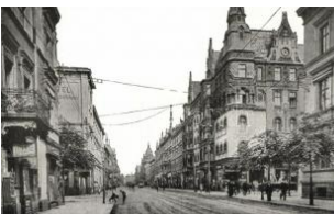
23115. * Katowice, Kattowitz; Grundmannstr. T1/2 2600
