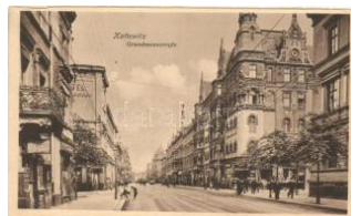
23114. * Katowice, Kattowitz; Grundmannstr. T2/3 2600
