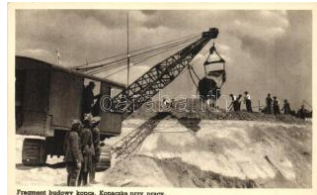
23106. ** Fragment budo wykopca. Kopaczka T1 1200
