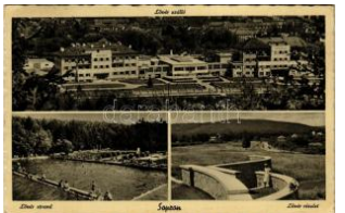
21551. 1940 Sopron, Lővér szálló és strand T2/3 2000
